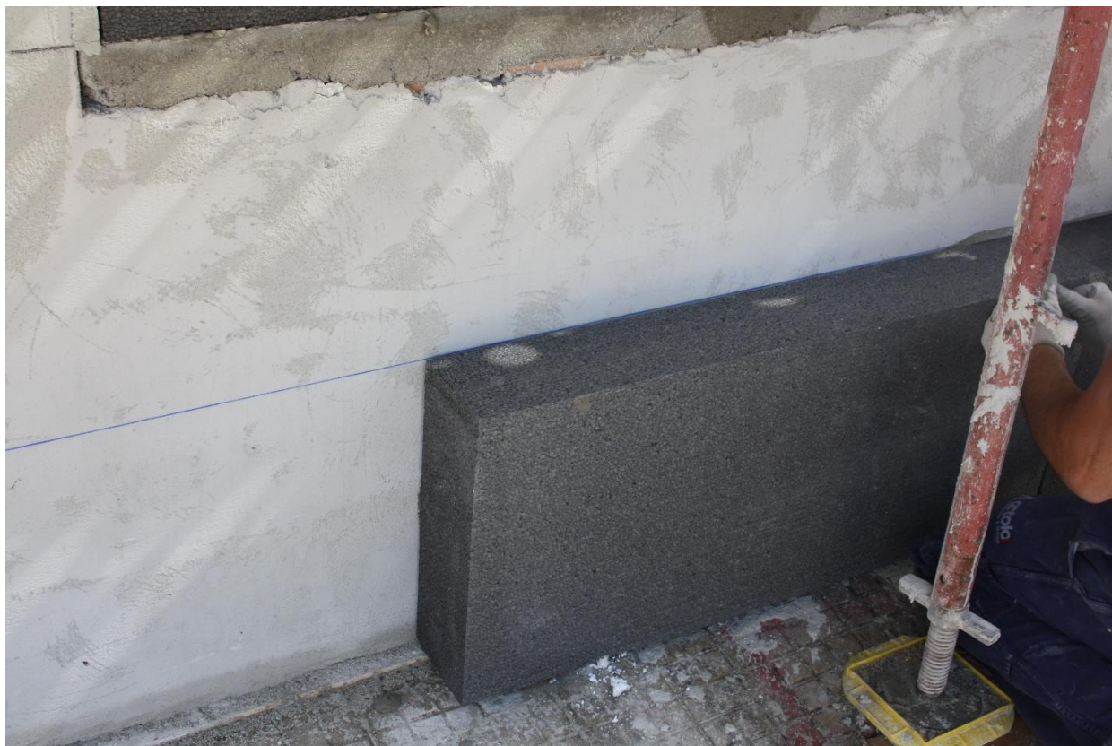
Figura 9 Realizzazione coibentazione esterna, rilievi fotografici del 13/05/2025
