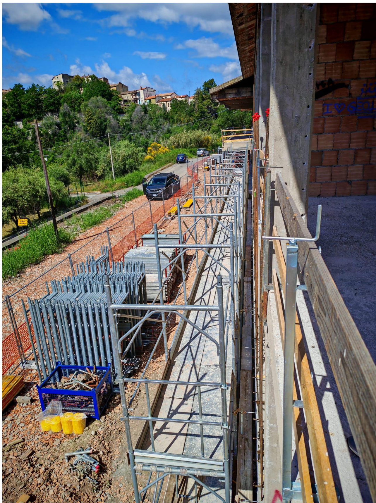
Figura 8 Installazione ponteggio, rilievo fotografico del 22/05/2025
