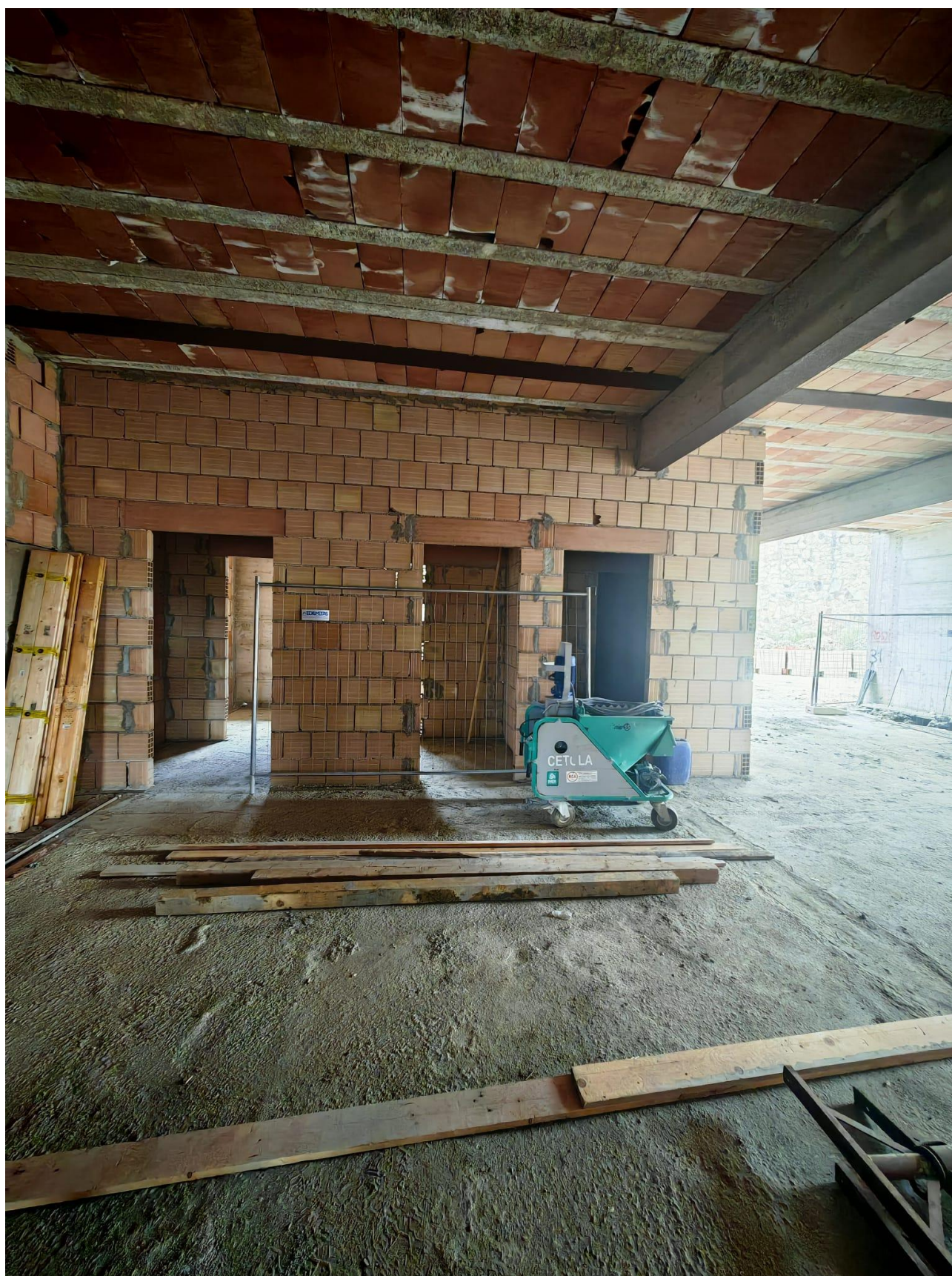
Figura 22 Realizzazione tramezzi interni, rilievo fotografico del 28/07/2025
