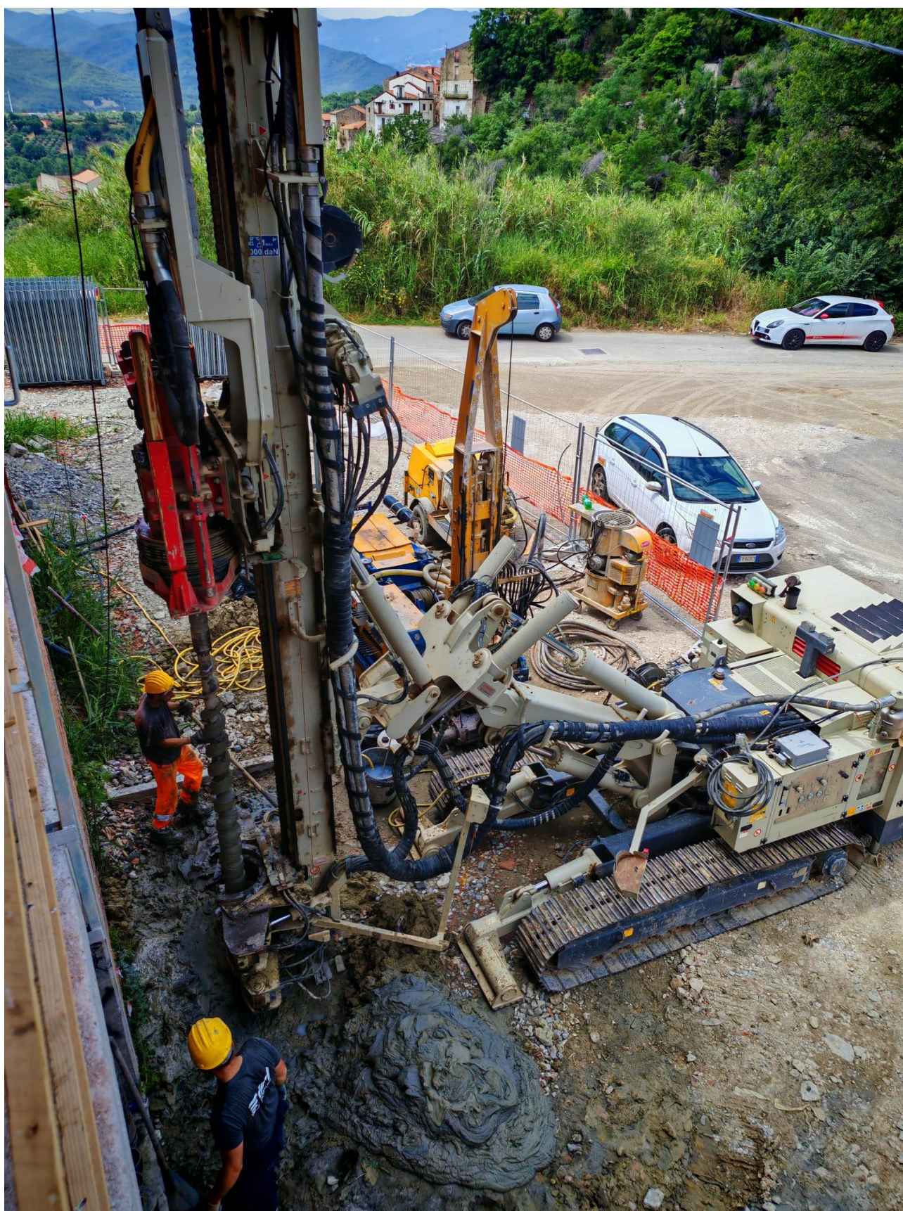
Figura 14 Esecuzione micropali, rilievo fotografico del 19/06/2025
