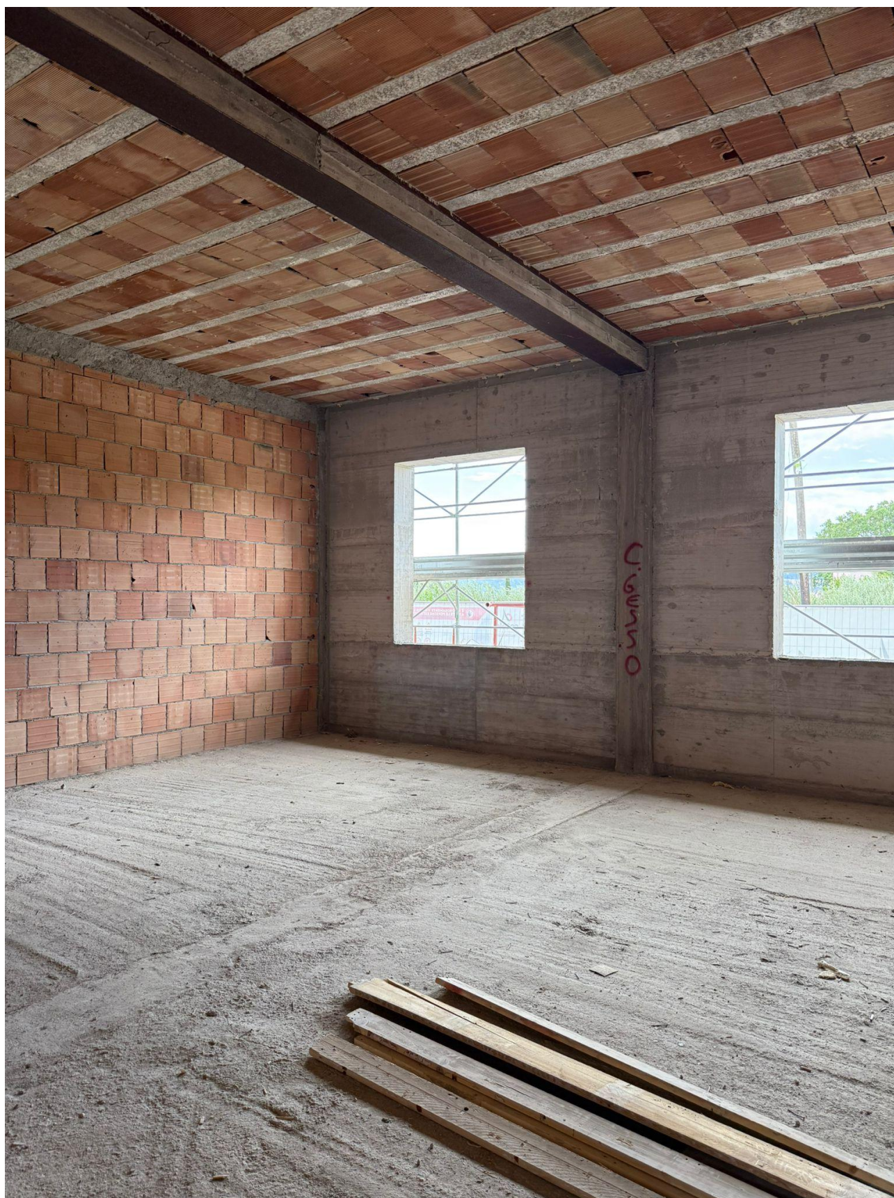
Figura 25 Rinforzo strutturale, rilievo fotografico del 28/07/2025
