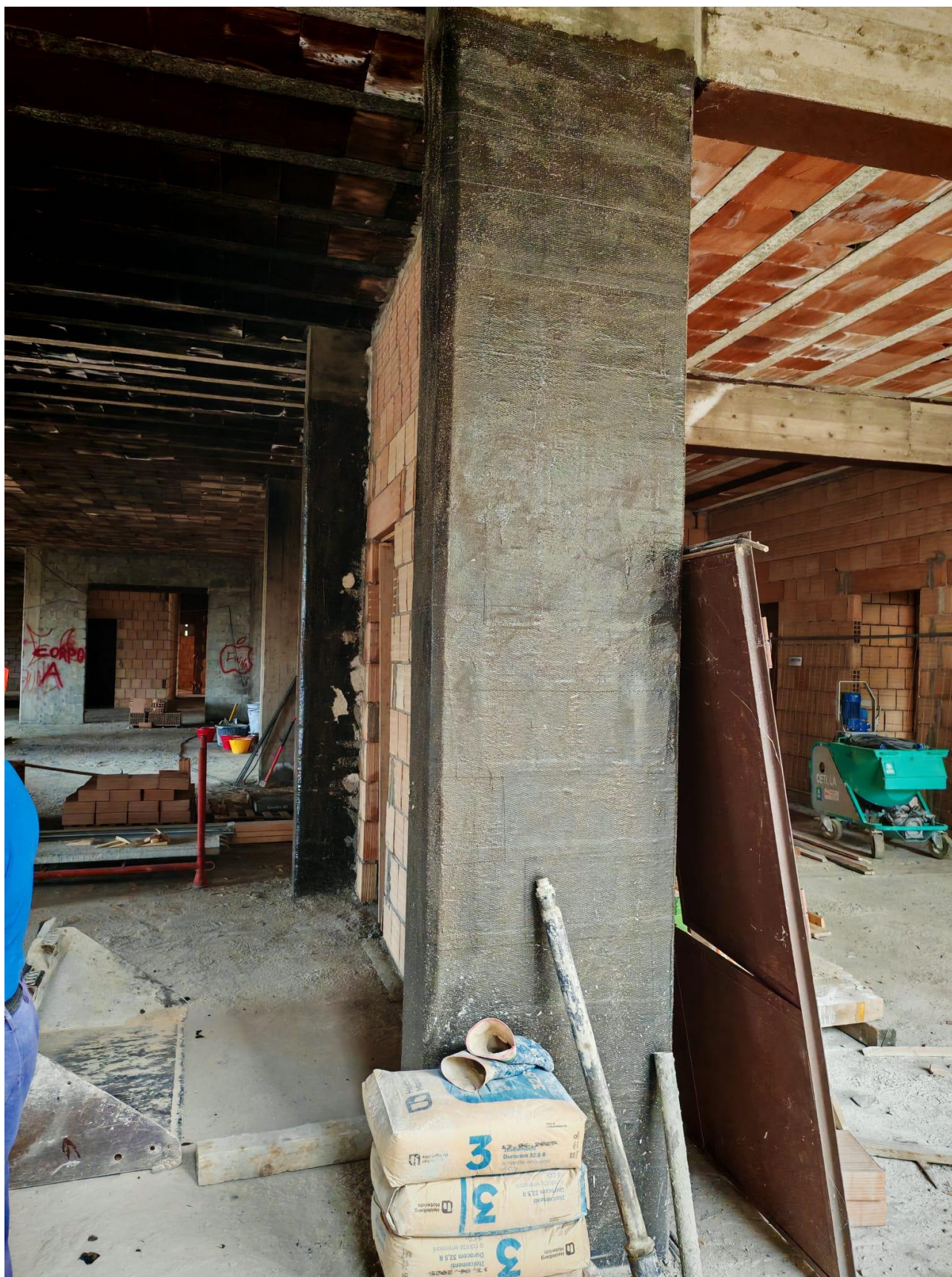
Figura 21 Rinforzo strutturale, rilievo fotografico del 28/07/2025
