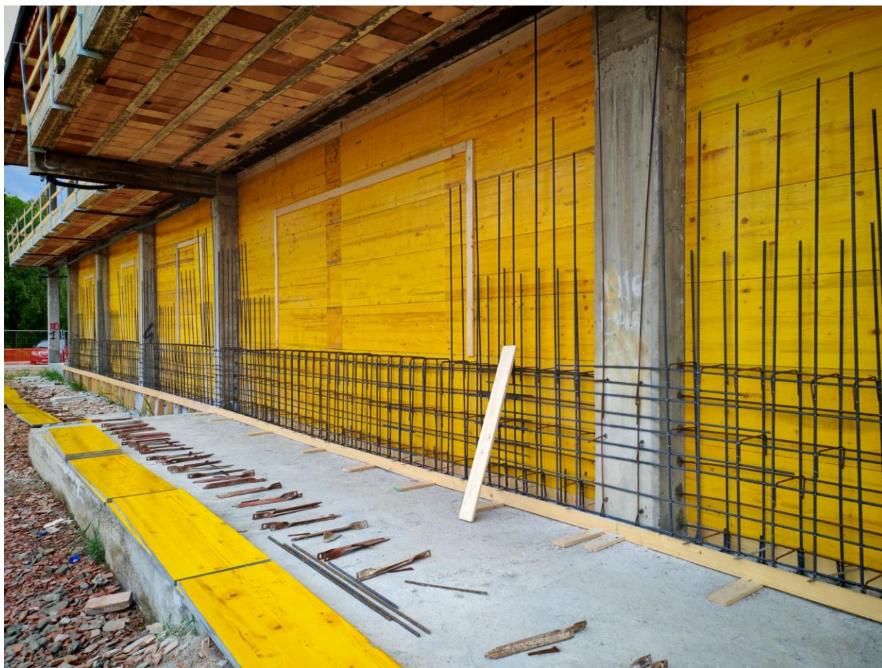
Figura 11 Opere di rinforzo strutturale, rilievo fotografico del 12/05/2025
