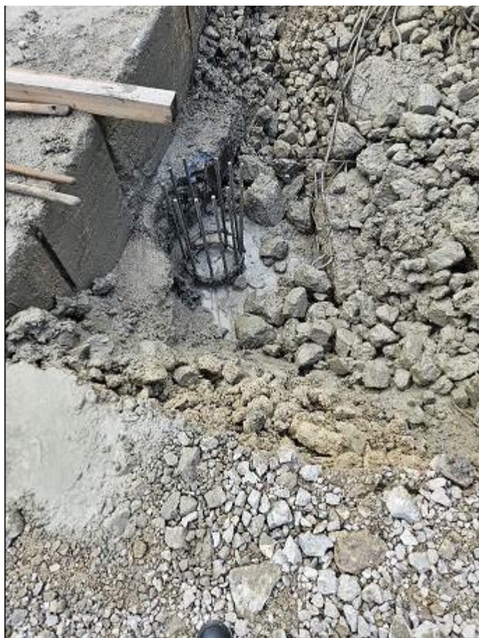
Figura 26 Getto e quota palo 8, rilievo fotografico del 19/11/2025
