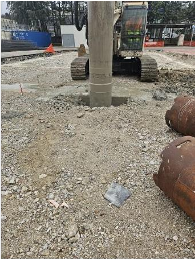
Figura 23 Getto palo di fondazione, rilievo fotografico del 19/11/2025
