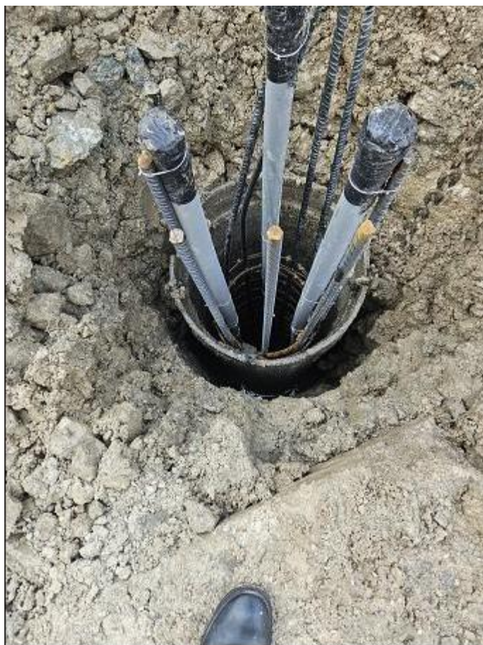
Figura 32 armatura palo con tubi per sonde, rilievo fotografico del 27/11/2025
