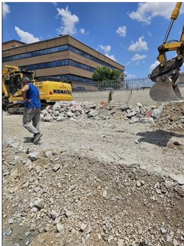
Figura 16 Demolizione soletta ca Corpo C, rilievo fotografico del 20/06/2025
