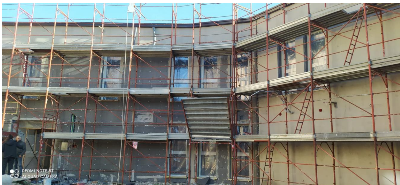
Figura 34 Rilievi fotografici del 19/12/2025
