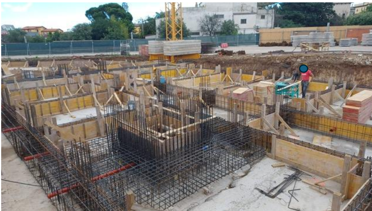
Figura 3 Realizzazione armatura plinti, rilievo fotografico del 03/06/2025
