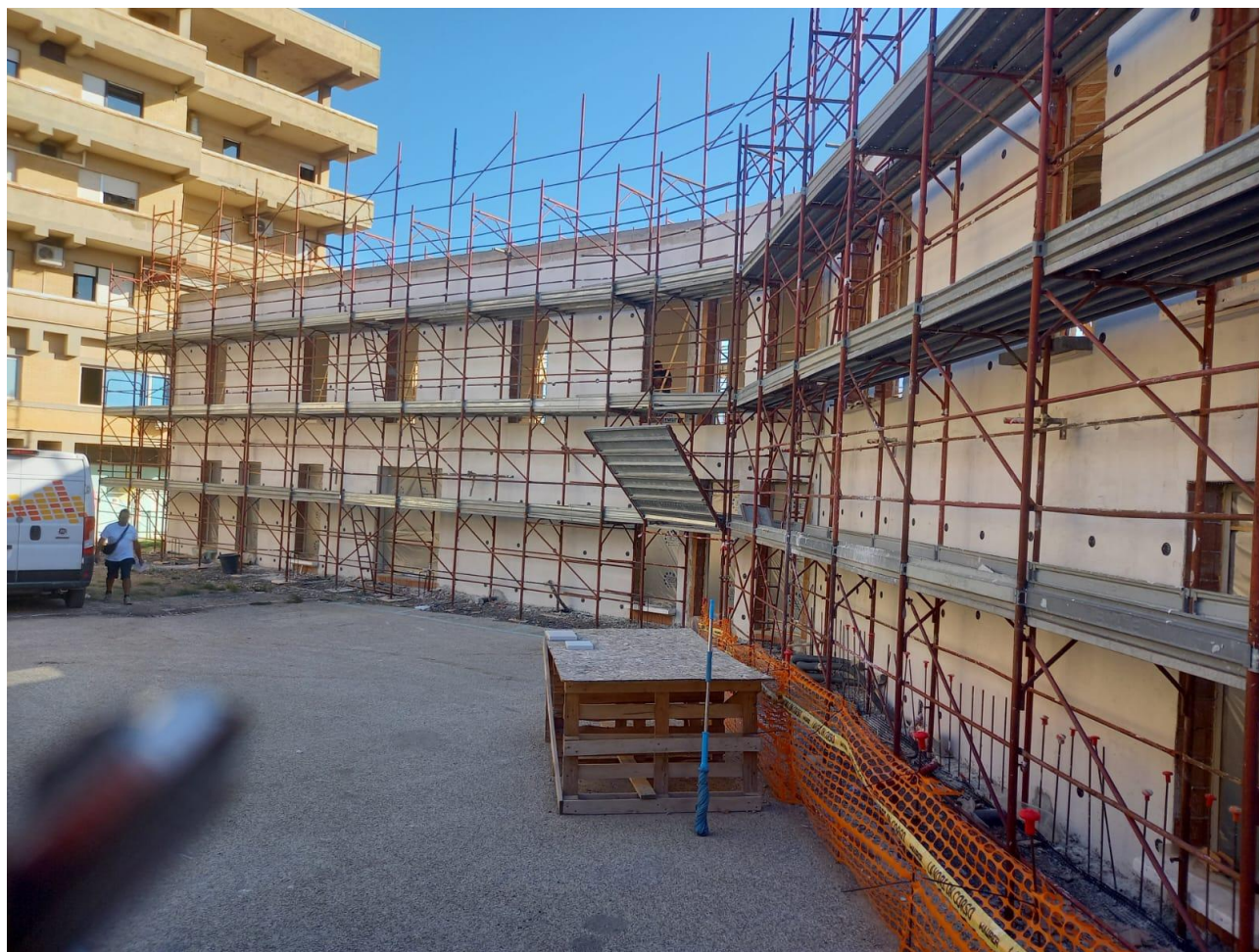
Figura 8 Rilievi fotografici del 19/09/2025
