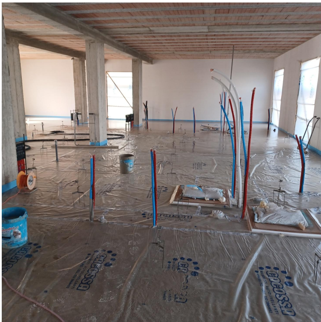
Figura 10 Rilievi fotografici del 19/09/2025
