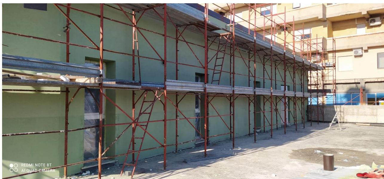
Figura 42 Rilievi fotografici del 19/12/2025
