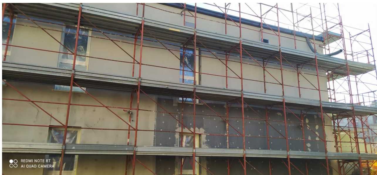
Figura 33 Rilievi fotografici del 19/12/2025
