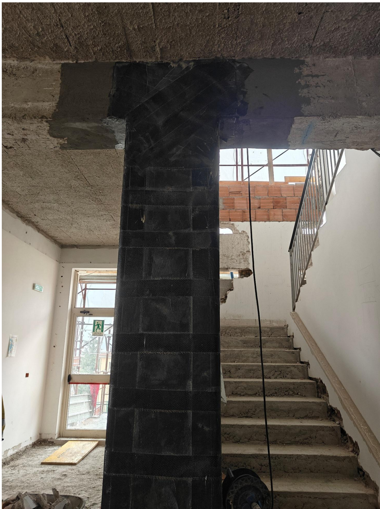
Figura 12 Rinforzo strutturale in fibra di carbonio, rilievo fotografico del 26/03/2025
