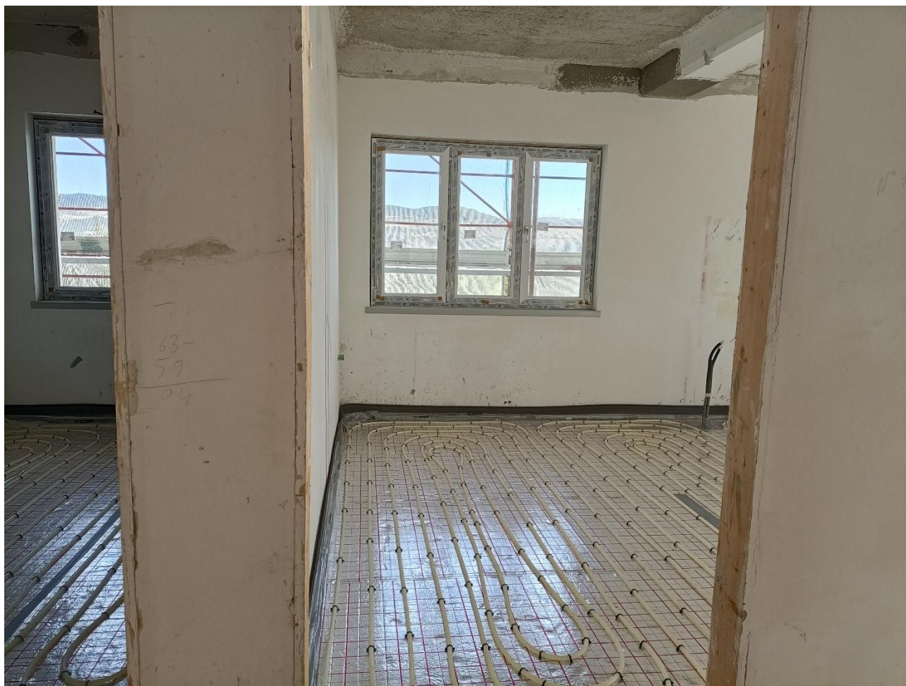
Figura 18 Installazione impianto di riscaldamento a pavimento, rilievo fotografico del 10/09/2025
