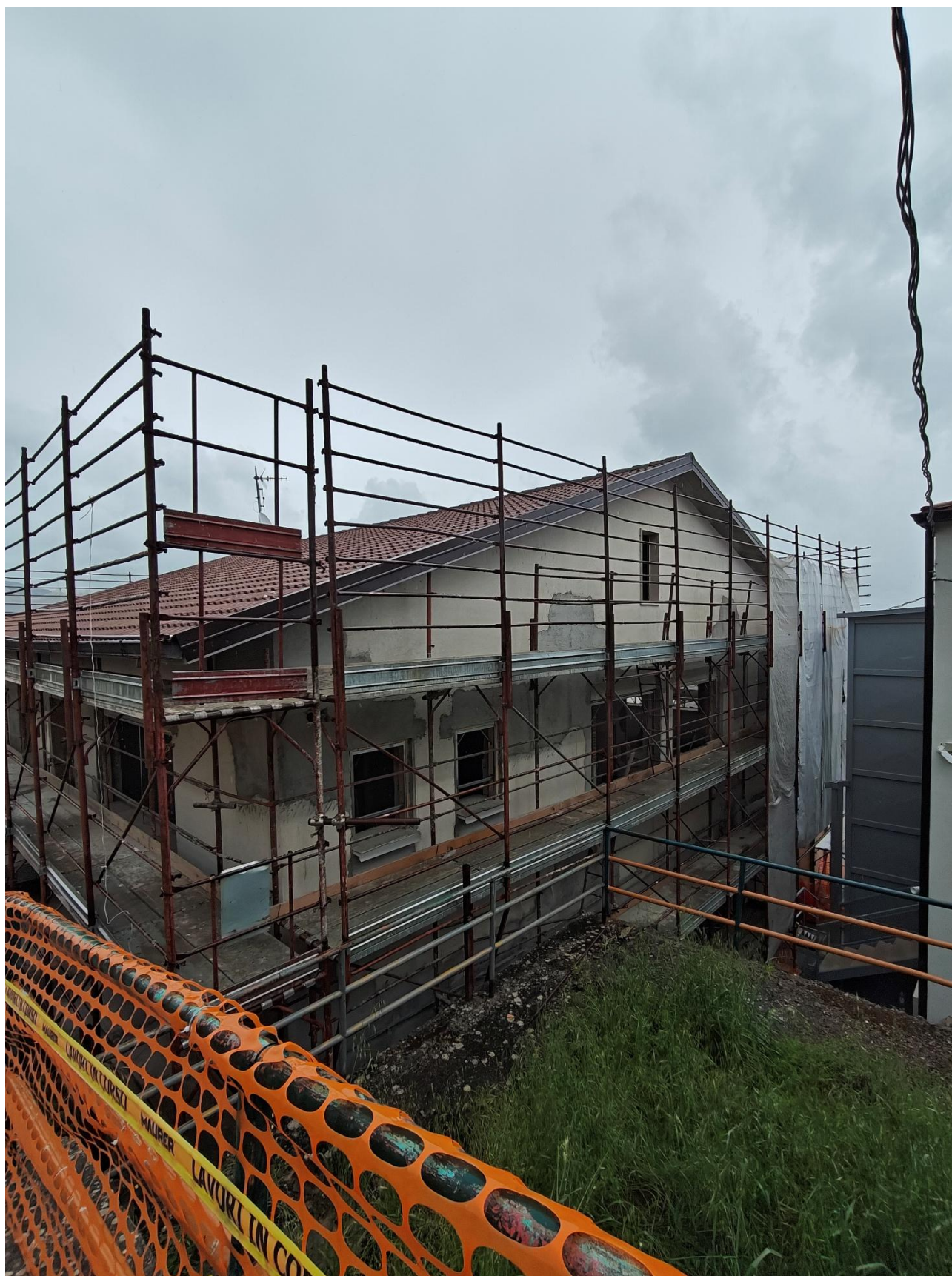
Figura 5 Installazione impalcato, rilievo fotografico del 15/05/2025
