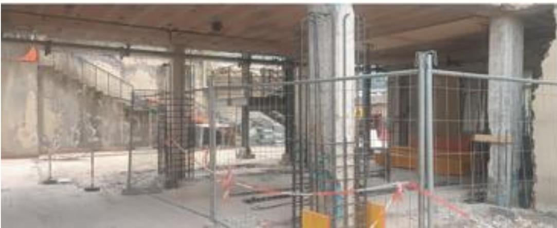
*Figura 9 Rinforzo strutturale, rilievo fotografico del 06/03/2025*
