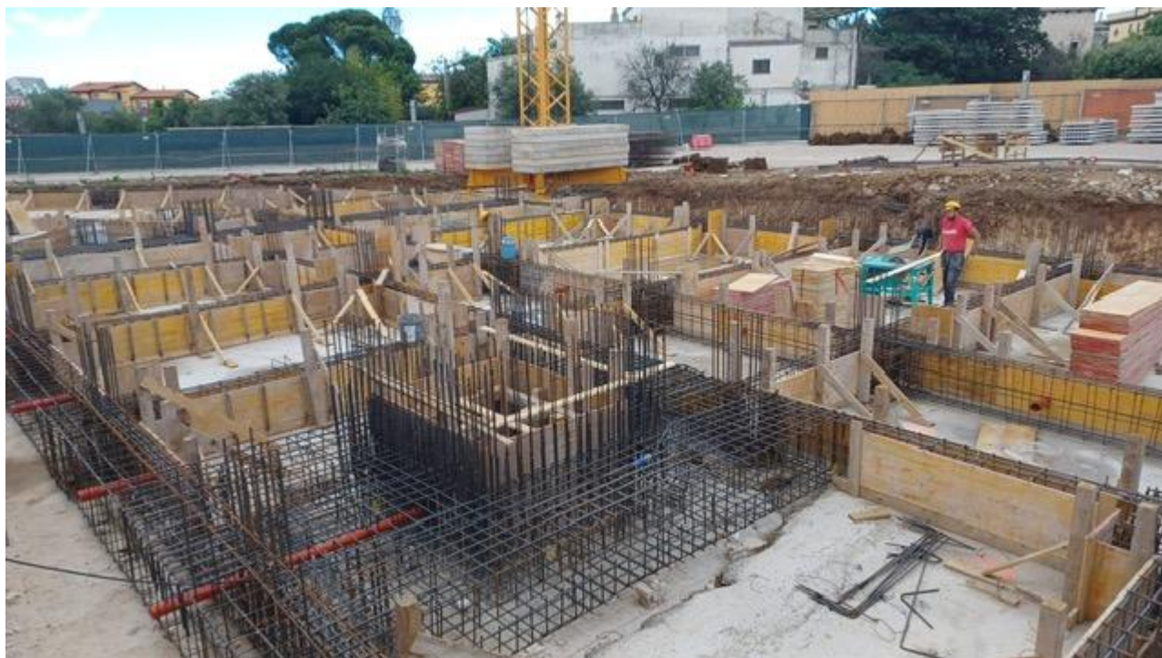
Figura 3 Realizzazione armatura plinti, rilievo fotografico del 03/06/2025
