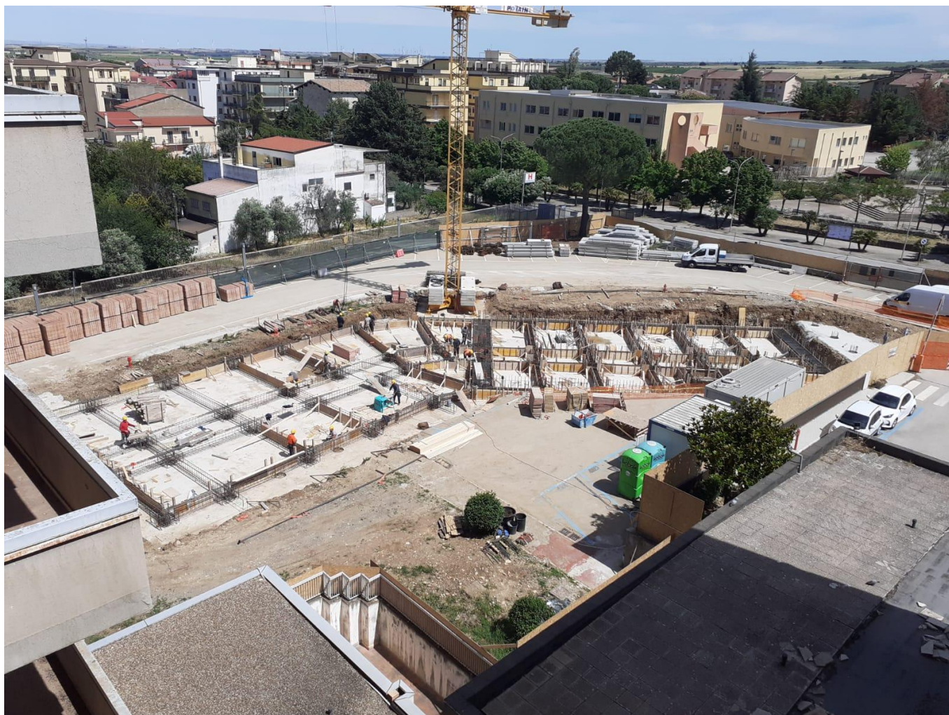
Figura 2 Realizzazione platea, rilievo fotografico del 03/06/2025
