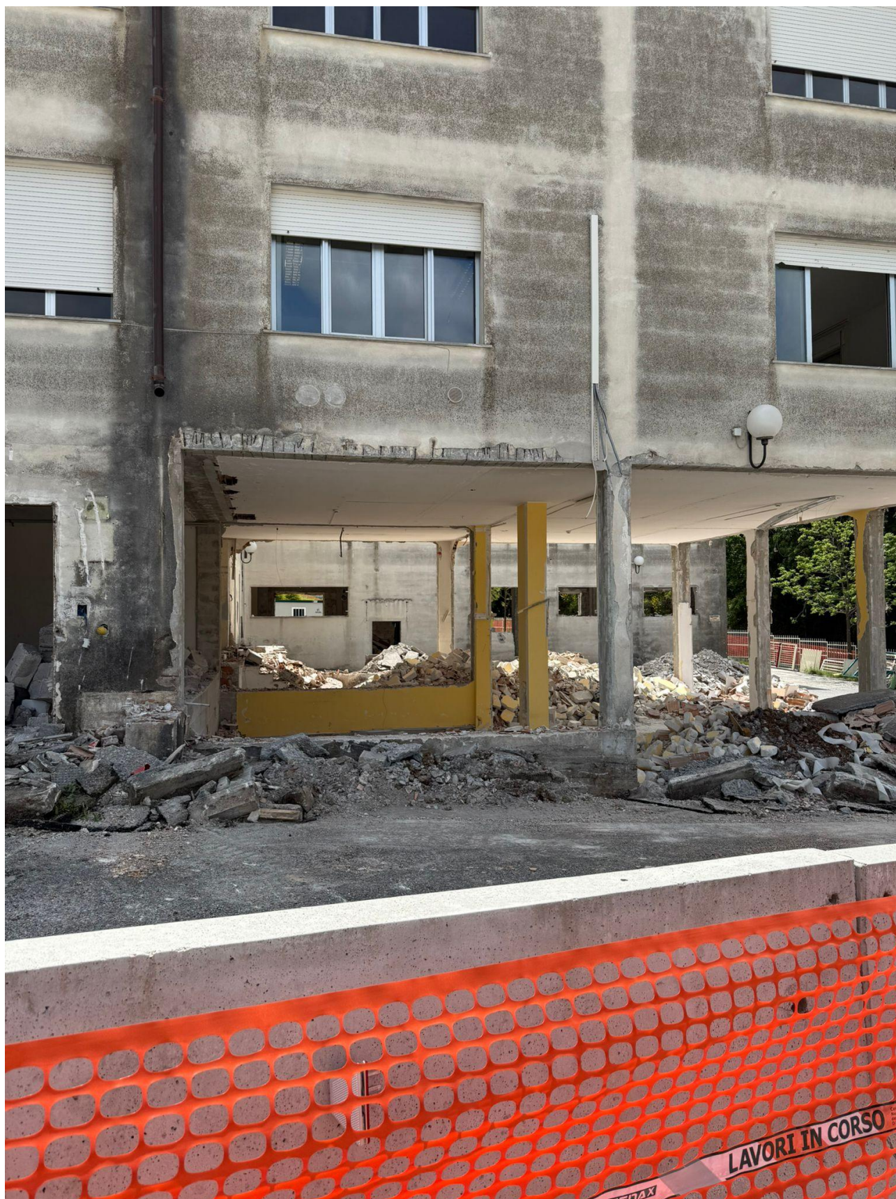
Figura 16 Demolizione tramezzi esterni, rilievi fotografici del 23/05/2025
