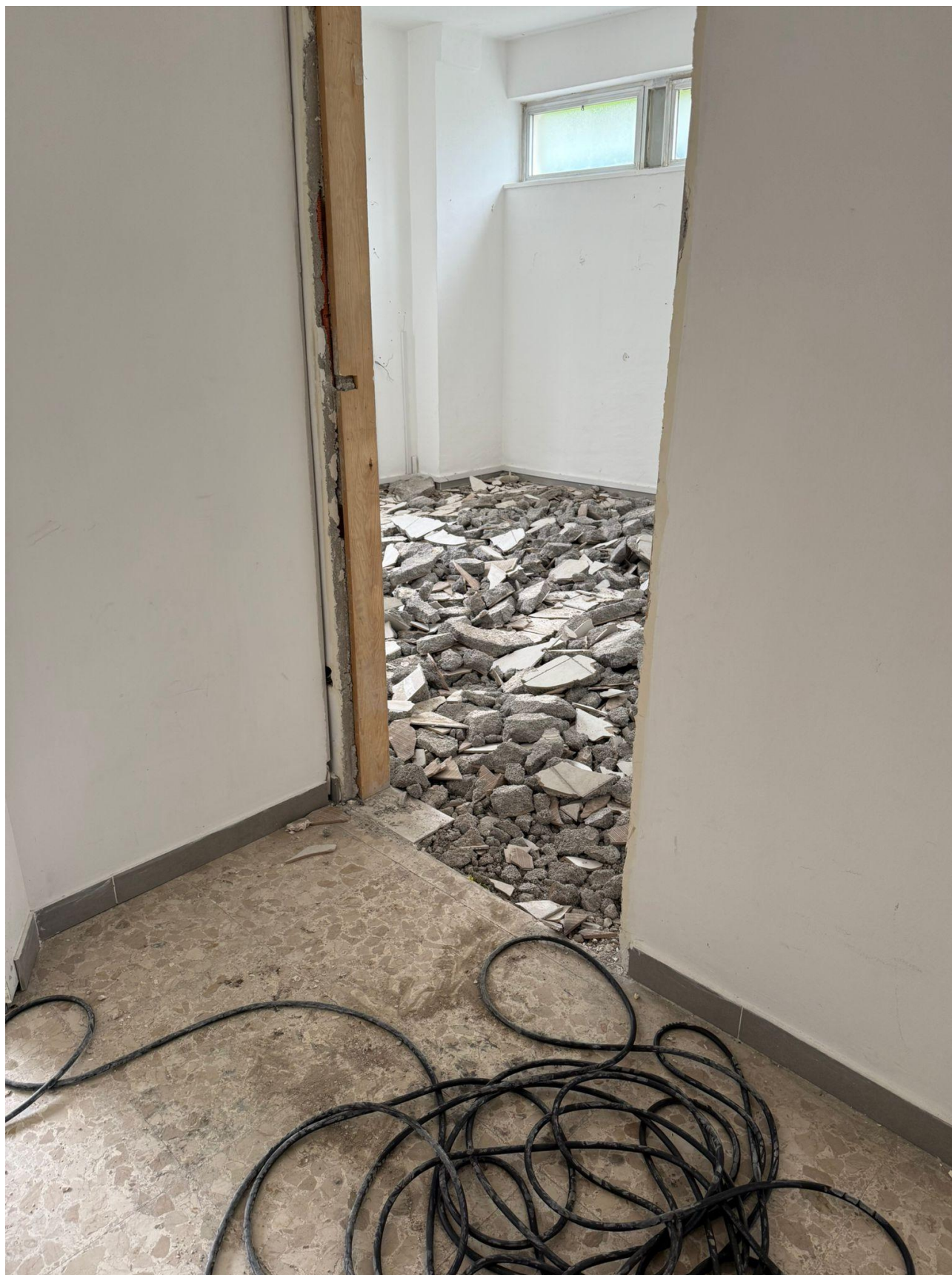
Figura 12 Demolizione pavimentazione interna, rilievi fotografici del 15/05/2025
