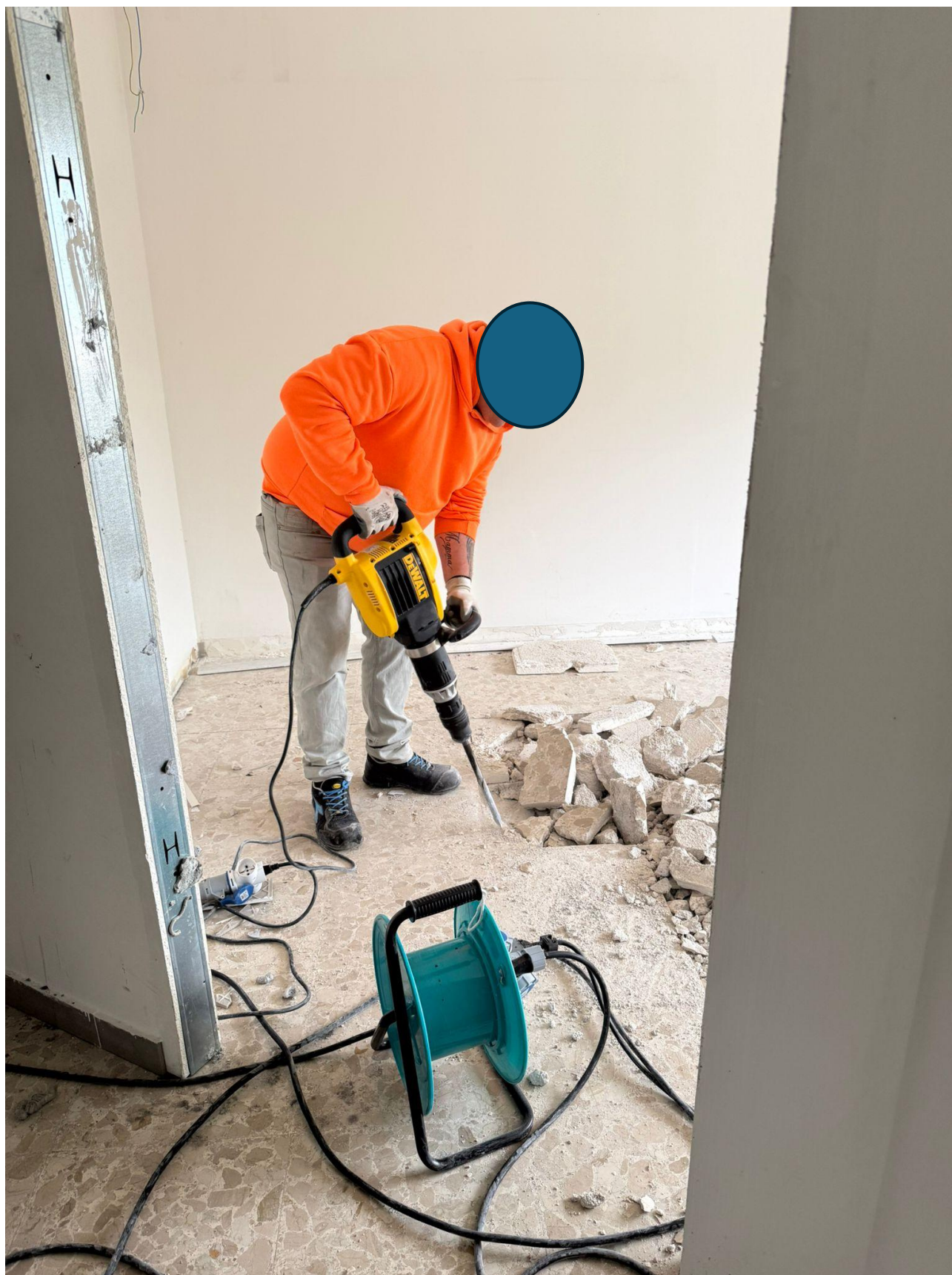
Figura 11 Demolizione pavimentazione interna, rilievi fotografici del 15/05/2025
