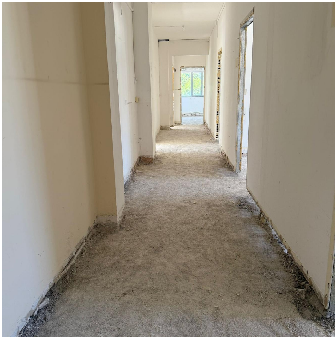
Figura 27 Demolizioni pavimentazione, rilievi fotografici del 27/06/2025
