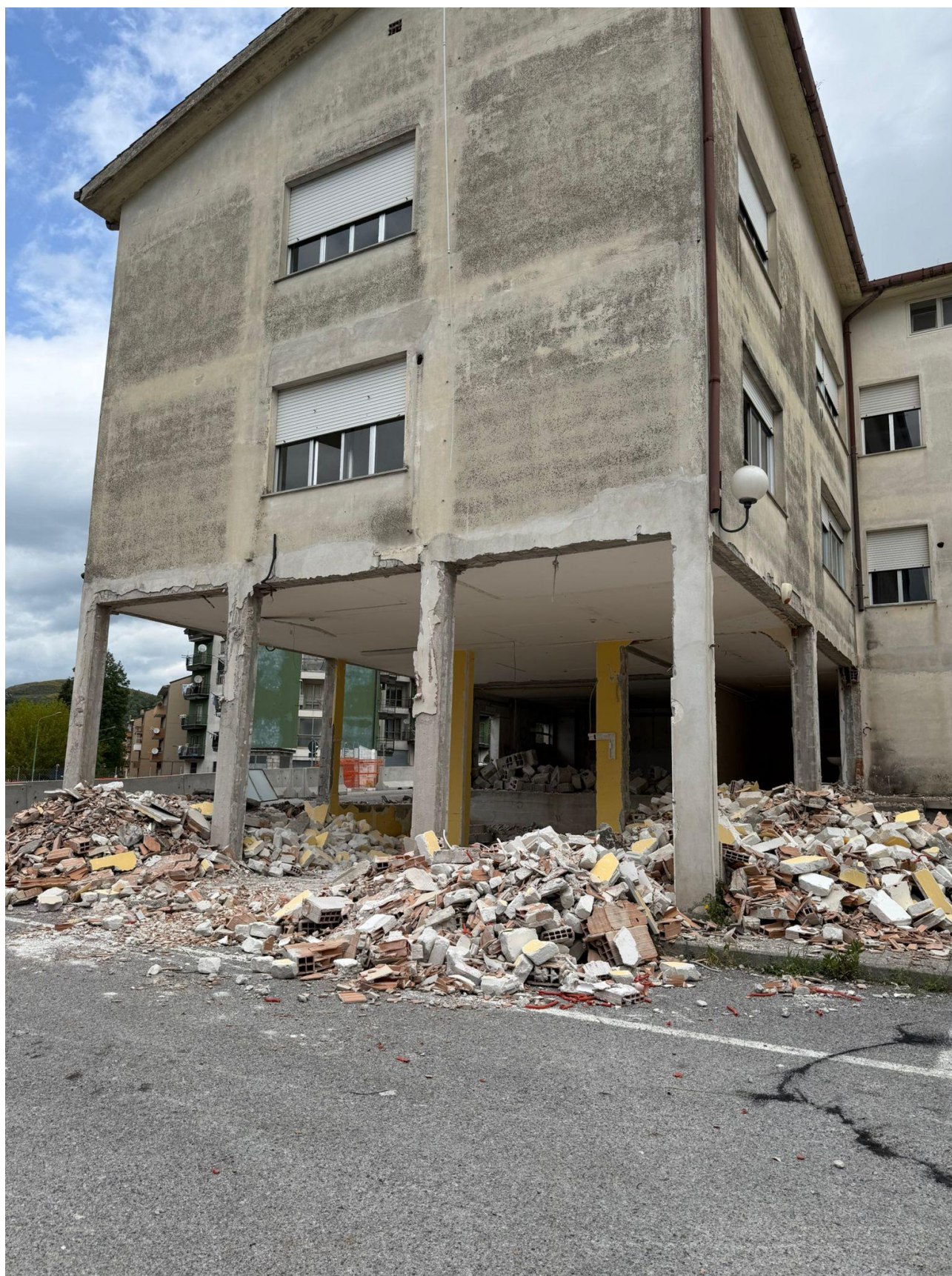
Figura 15 Demolizione tramezzi esterni, rilievi fotografici del 23/05/2025
