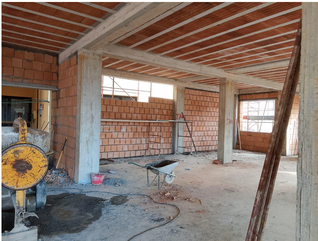
Figura 24 Realizzazione pareti divisorie esterne, rilievi fotografici del 15/03/2025
