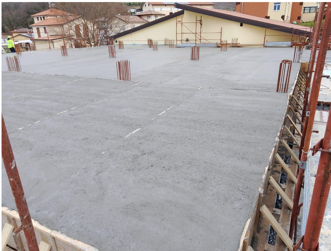
Figura 9 Realizzazione solaio primo piano, rilievi fotografici 15/11/2024
