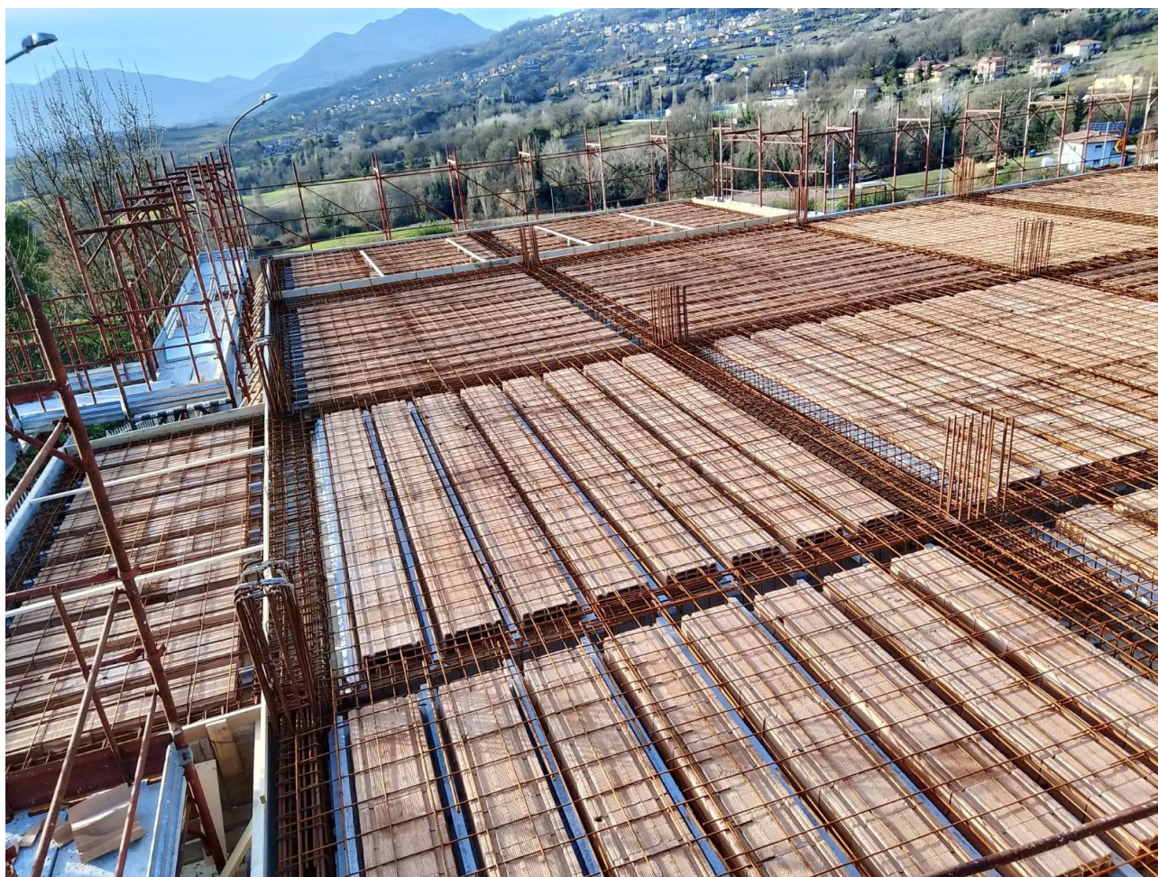
Figura 13 Realizzazione solaio, rilievo fotografico del 14/04/2025
