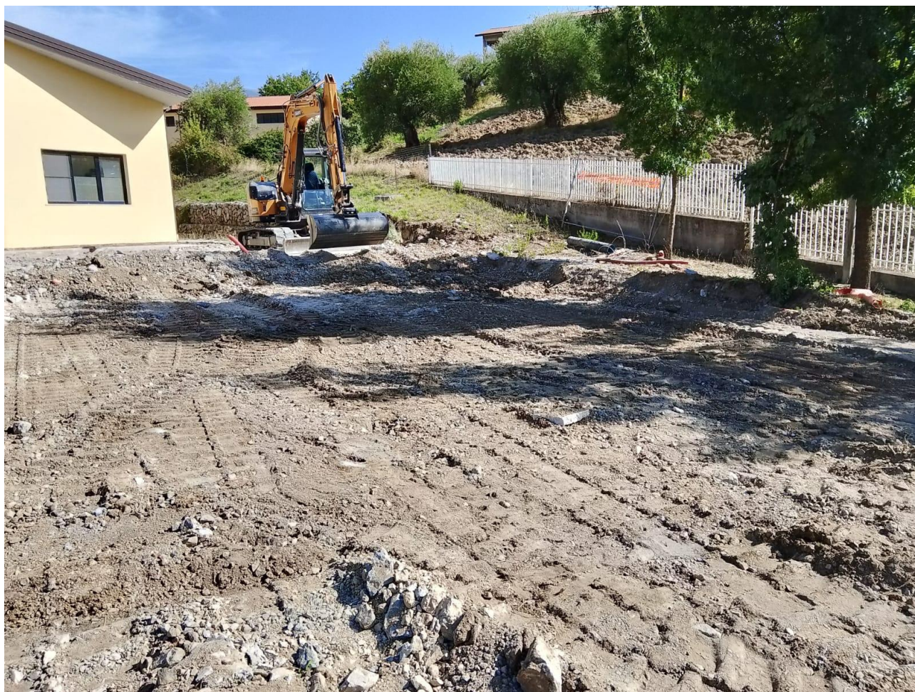
Figura 2 Sbancamento, rilievo fotografico del 10/09/2024
