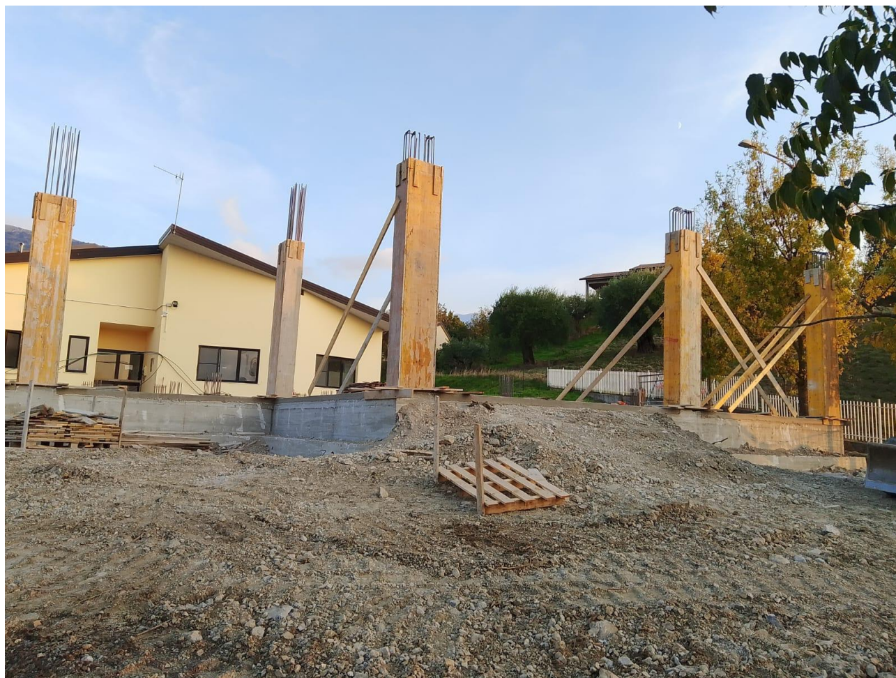
Figura 8 Armatura pilasti, rilievo fotografico del 10/10/2024
