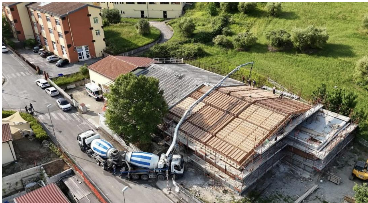
Figura 19 Getto calcestruzzo tetto, rilievi fotografici del 09/06/2025
