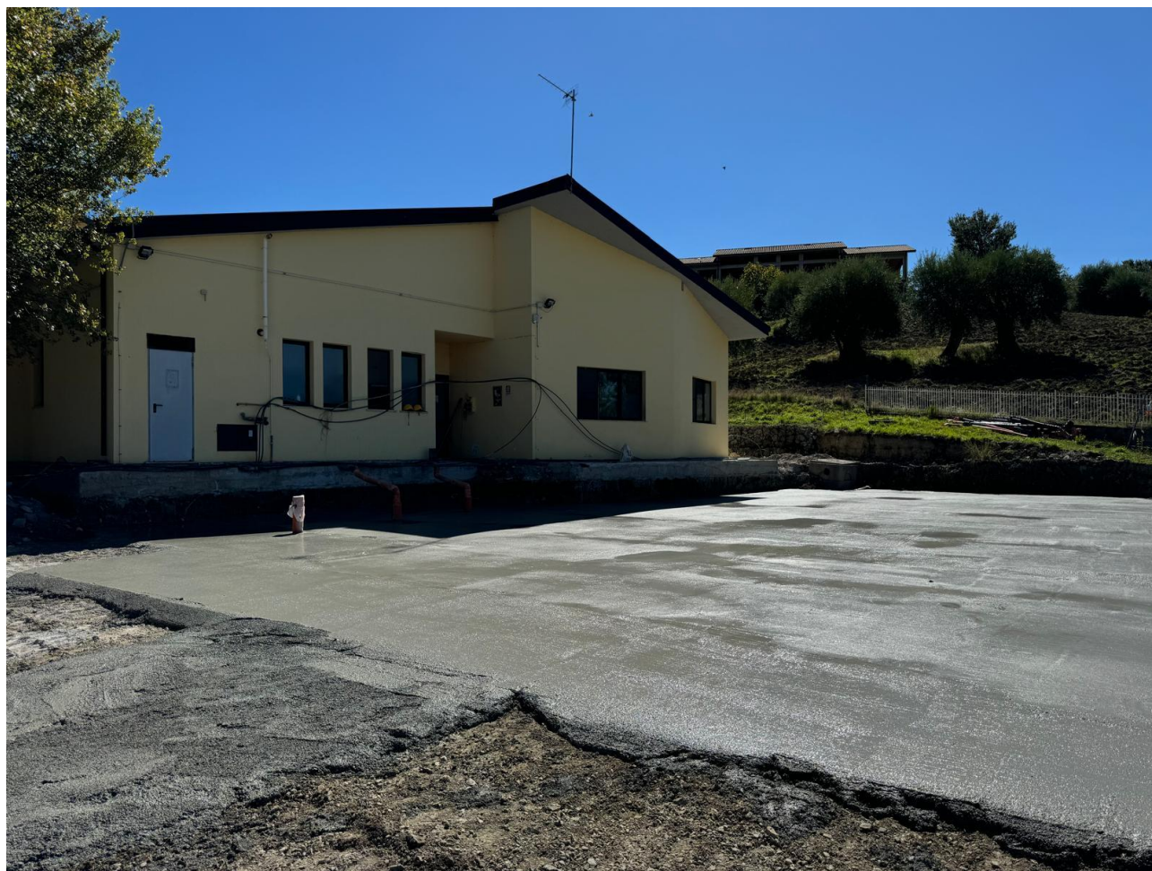
Figura 3 Realizzazione piano di posa fondazione, rilievo fotografico del 15/09/2024
