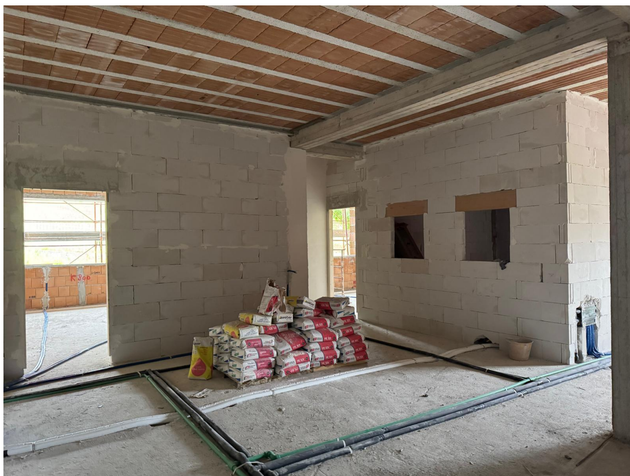
Figura 25 Realizzazione tramezzi, rilievi fotografici del 23/05/2025
