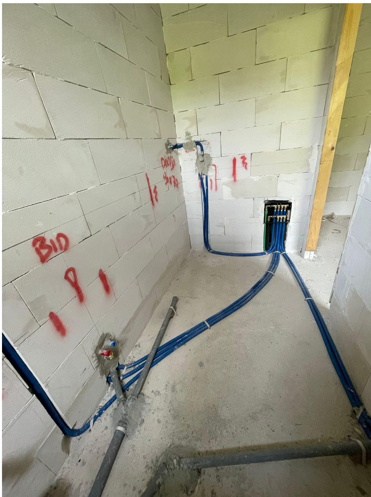
Figura 26 Realizzazione impianti idraulici, rilievo fotografico del 26/06/2025
