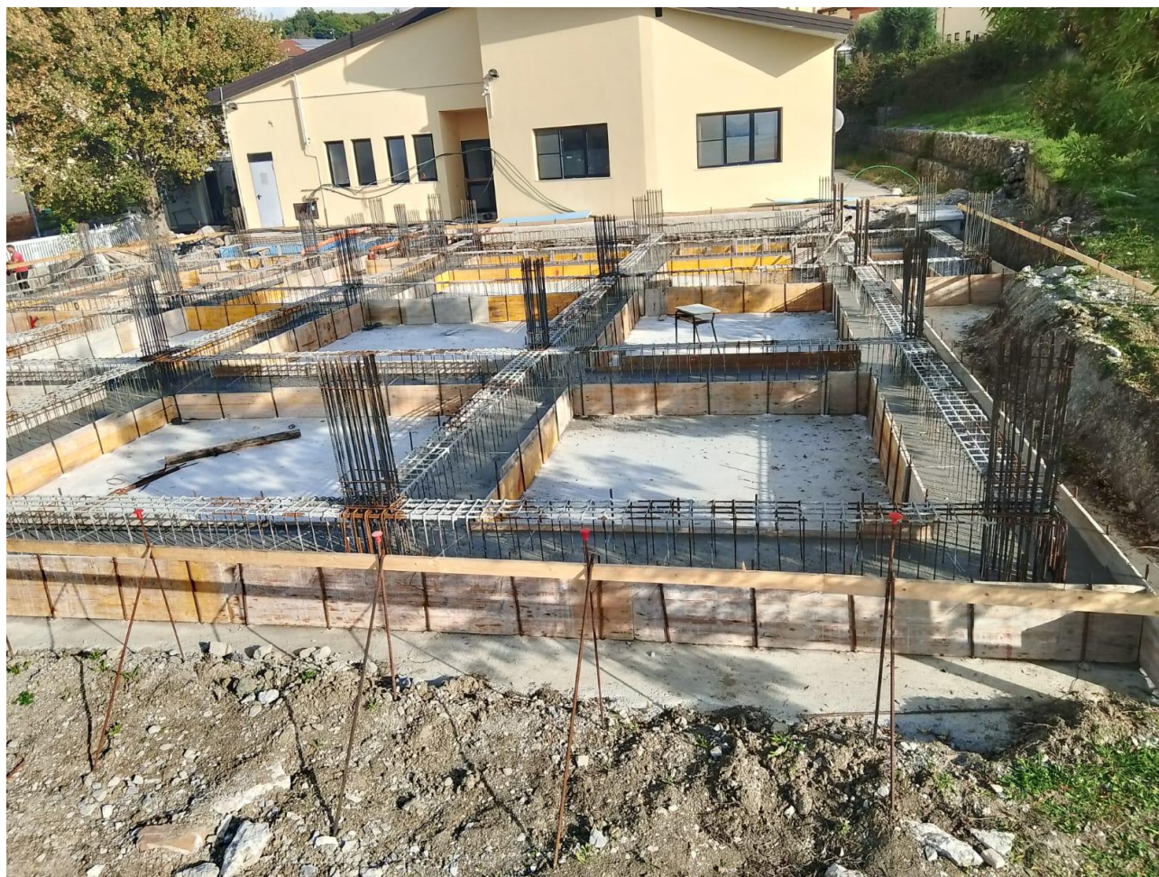
Figura 5 Armatura fondazioni, rilievo fotografico del 20/09/2024
