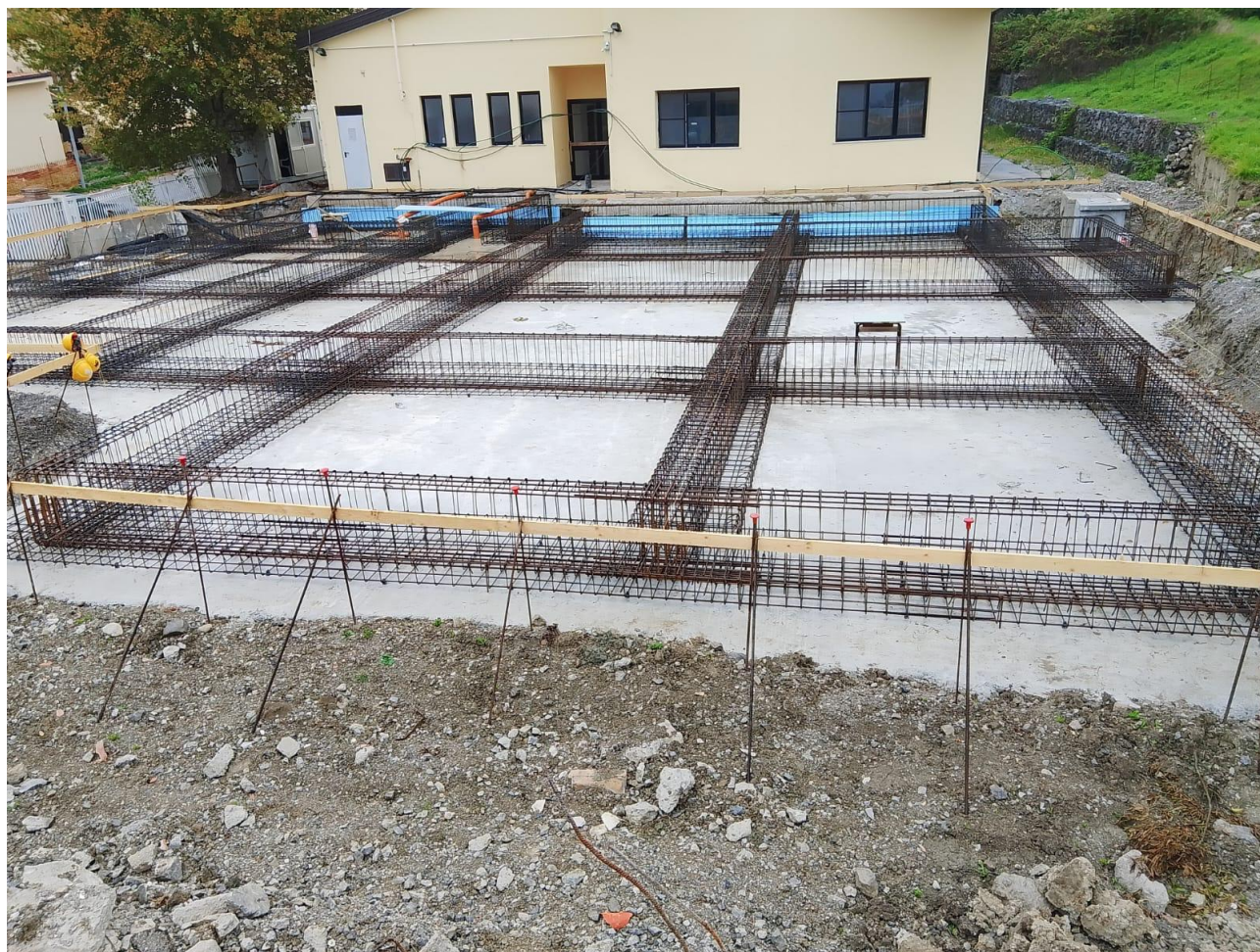
Figura 4 Armatura formazioni, rilievi fotografici del 15/09/2024
