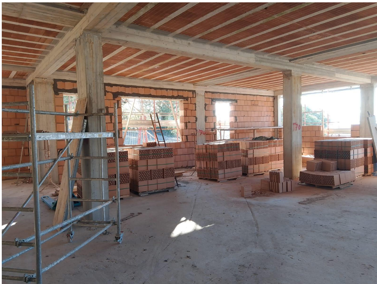
Figura 23 Realizzazione pareti divisorie esterne, rilievi fotografici del 15/03/2025
