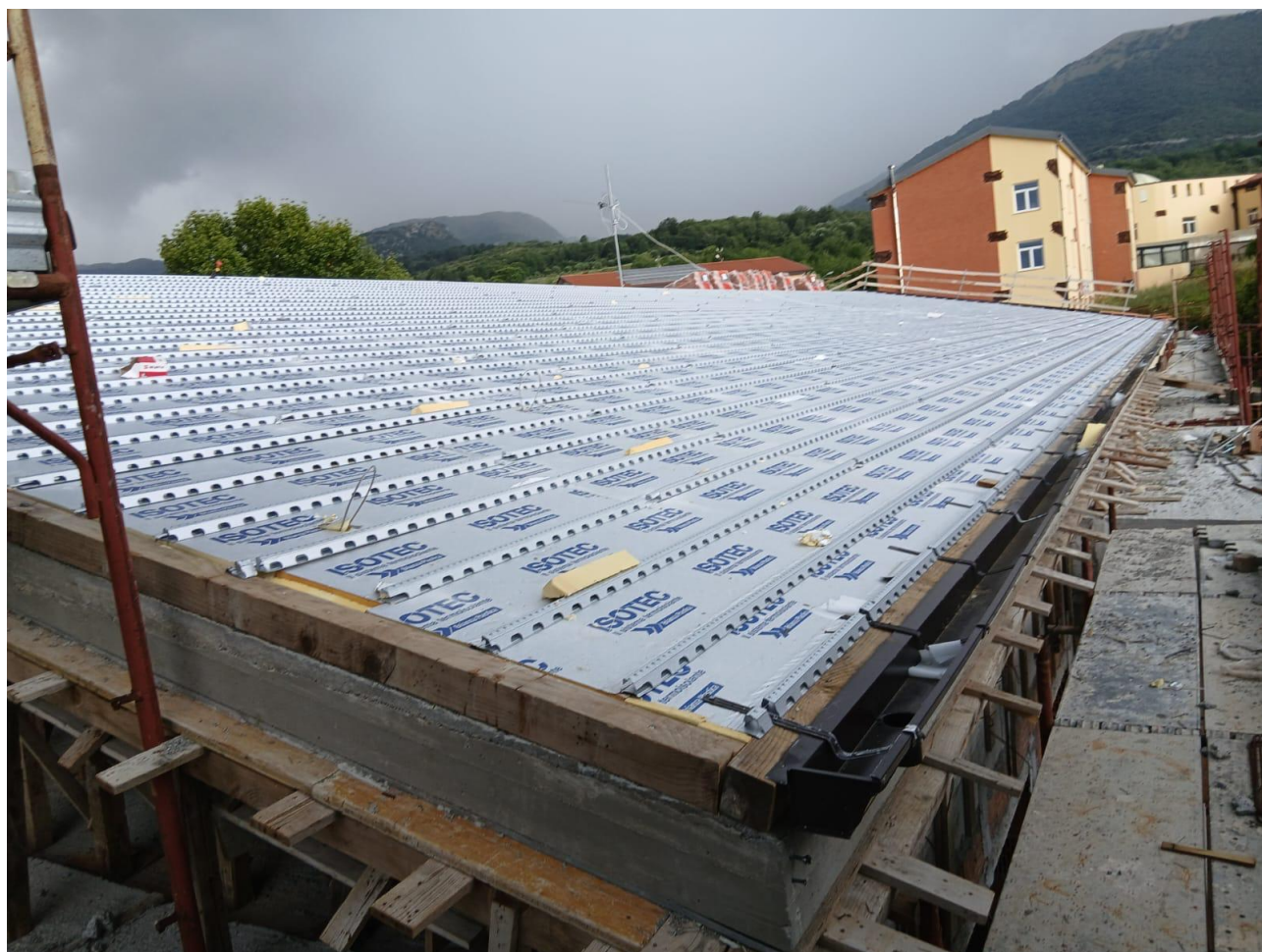
Figura 20 Coibentazione tetto, rilievo fotografico del 18/06/2025
