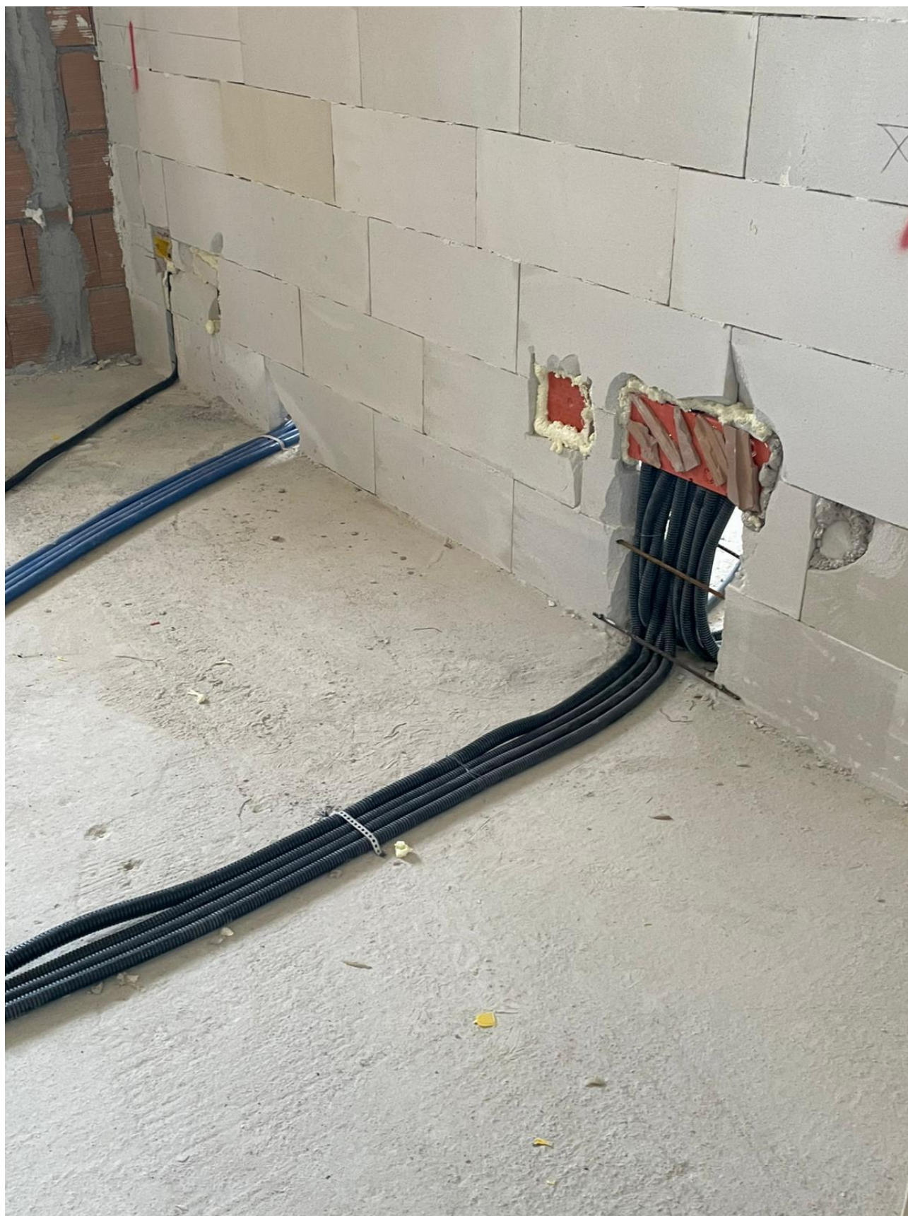
Figura 28 Realizza impianto elettrico, rilievo fotografico del 26/06/2025
