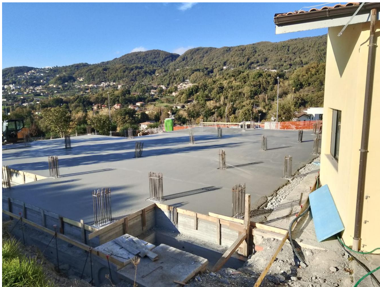
Figura 7 Realizzazione platea, rilievo fotografico del 25/09/2024
