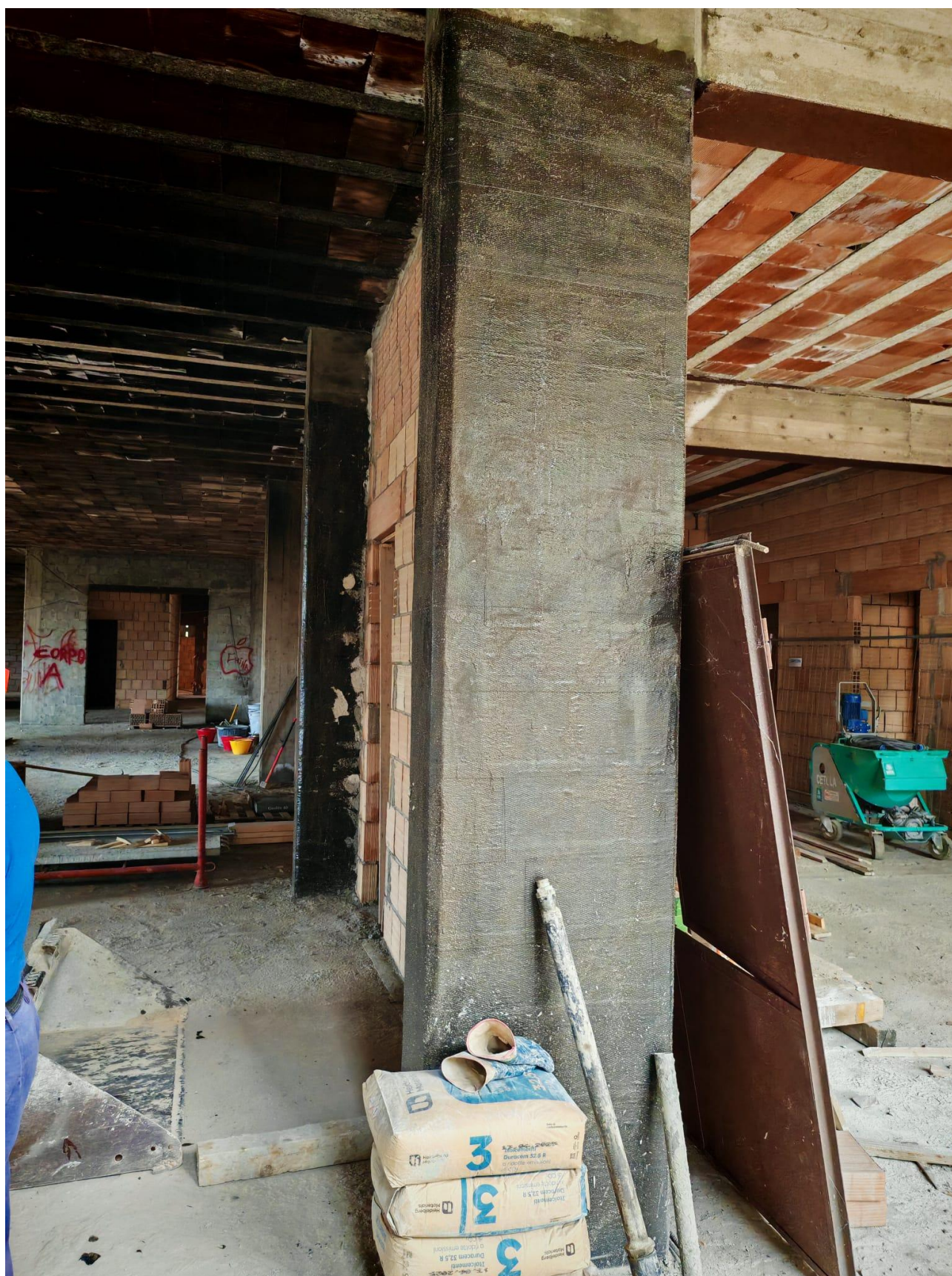
Figura 21 Rinforzo strutturale, rilievo fotografico del 28/07/2025
