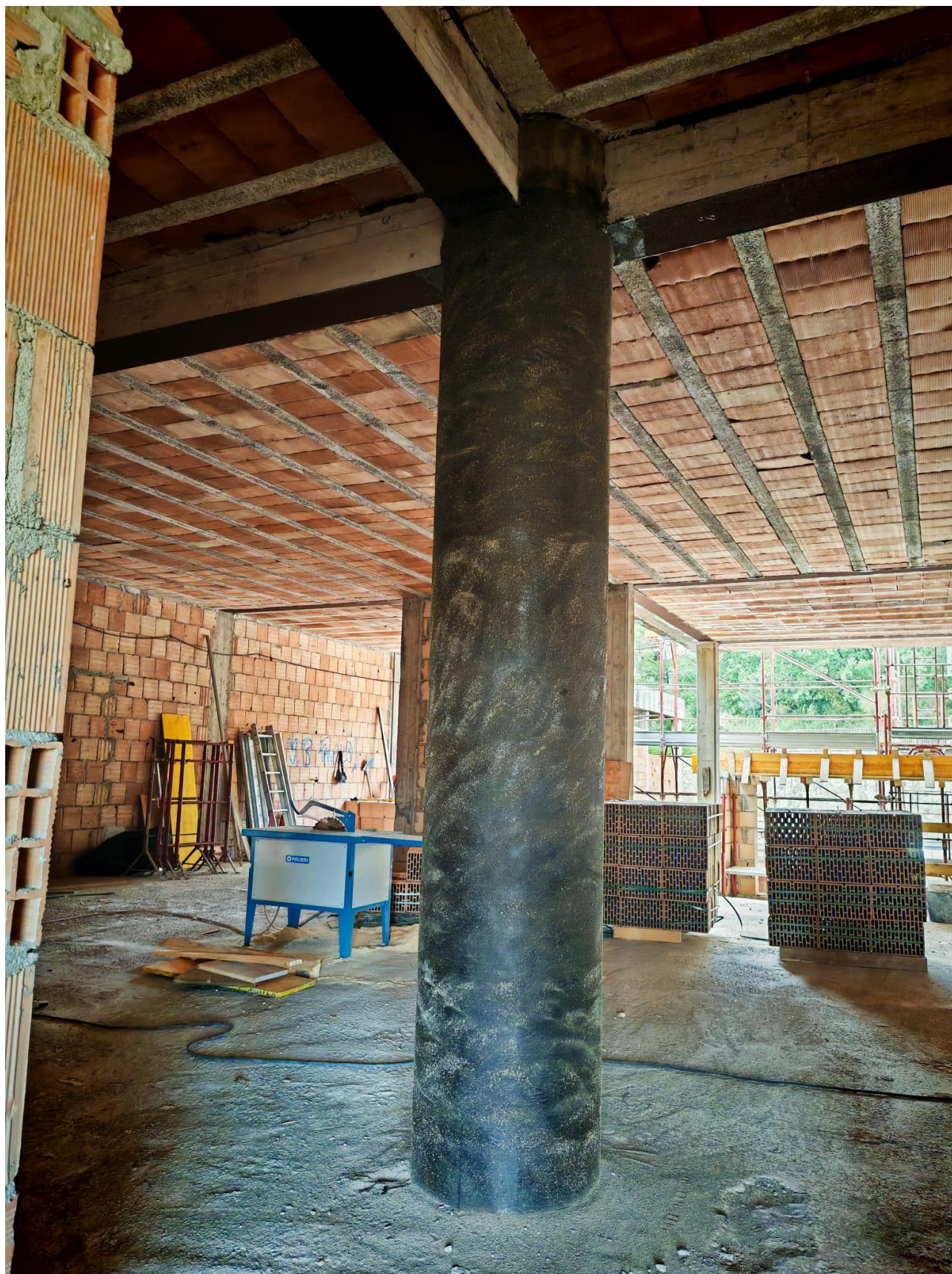
Figura 20 Rinforzo strutturale, rilievo fotografico del 28/07/2025
