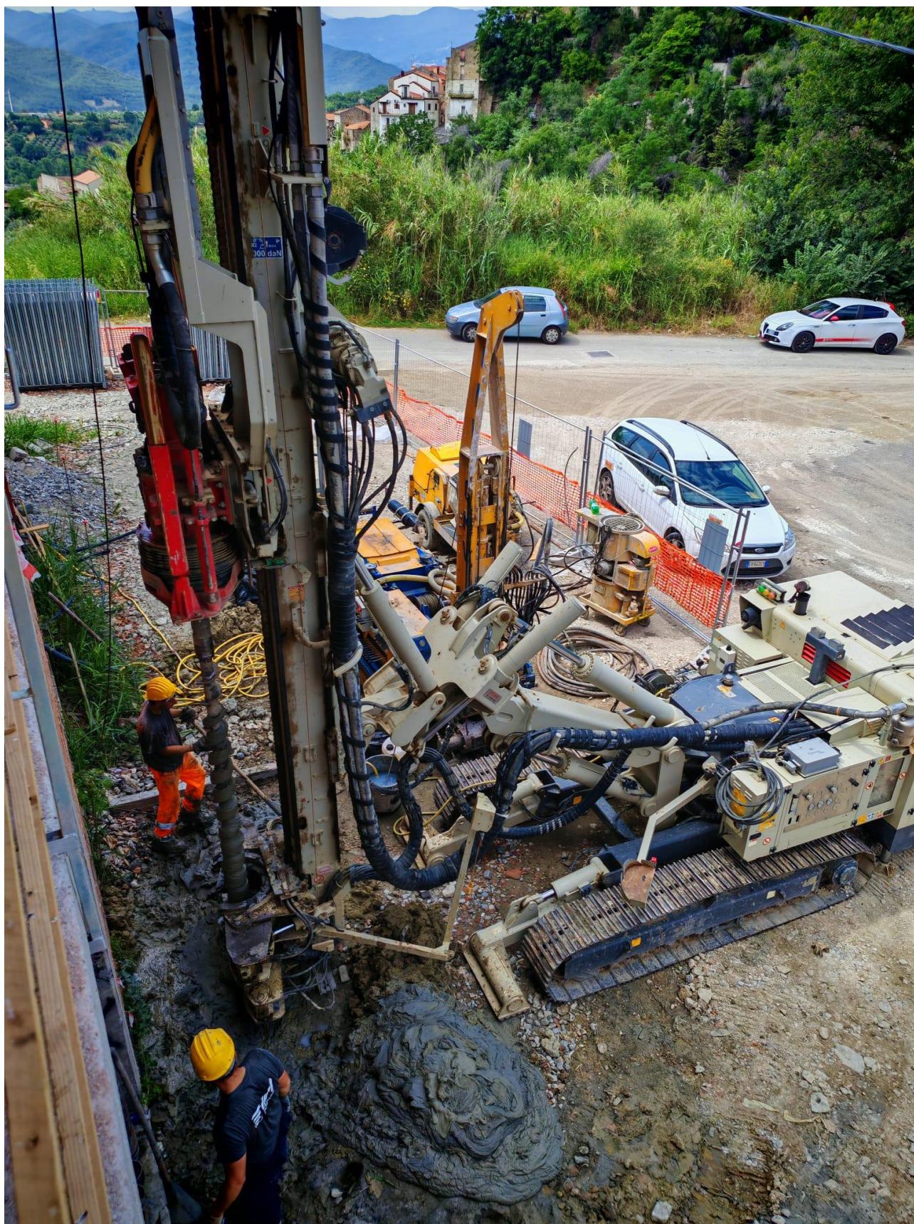
Figura 14 Esecuzione micropali, rilievo fotografico del 19/06/2025
