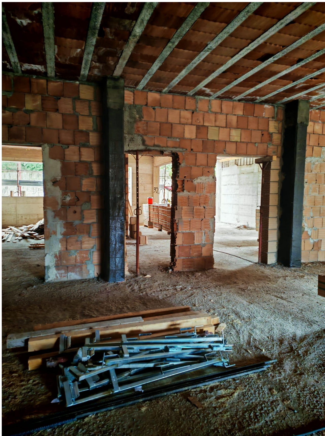
Figura 16 Rinforzo strutturale, rilievo fotografico del 28/07/2025
