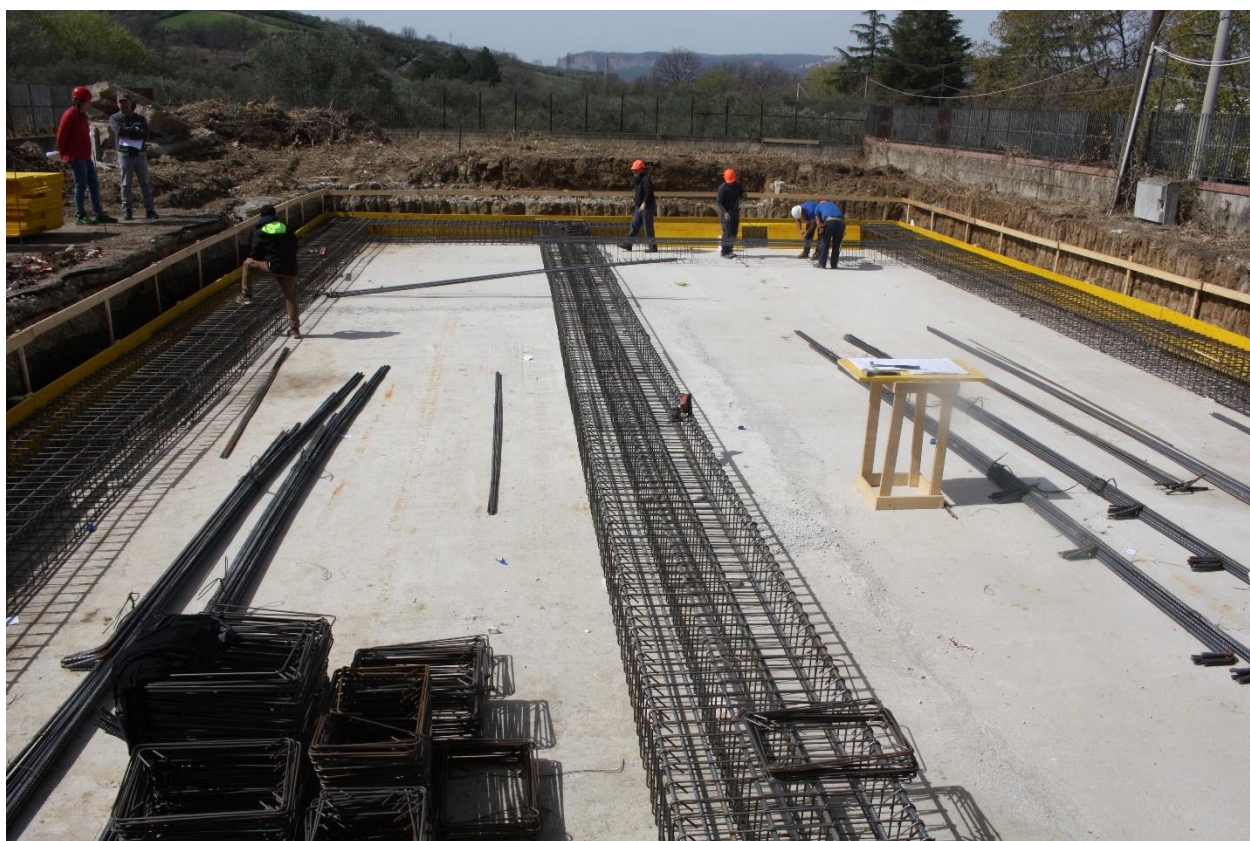
Figura 13 Armatura platea, rilievi fotografici del 20/03/2025
