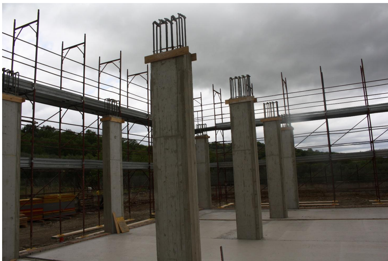
Figura 19 Realizzazione pilastri e platea , rilievi fotografici del 17/04/2025
