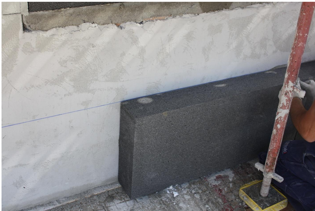
Figura 9 Realizzazione coibentazione esterna, rilievi fotografici del 13/05/2025
