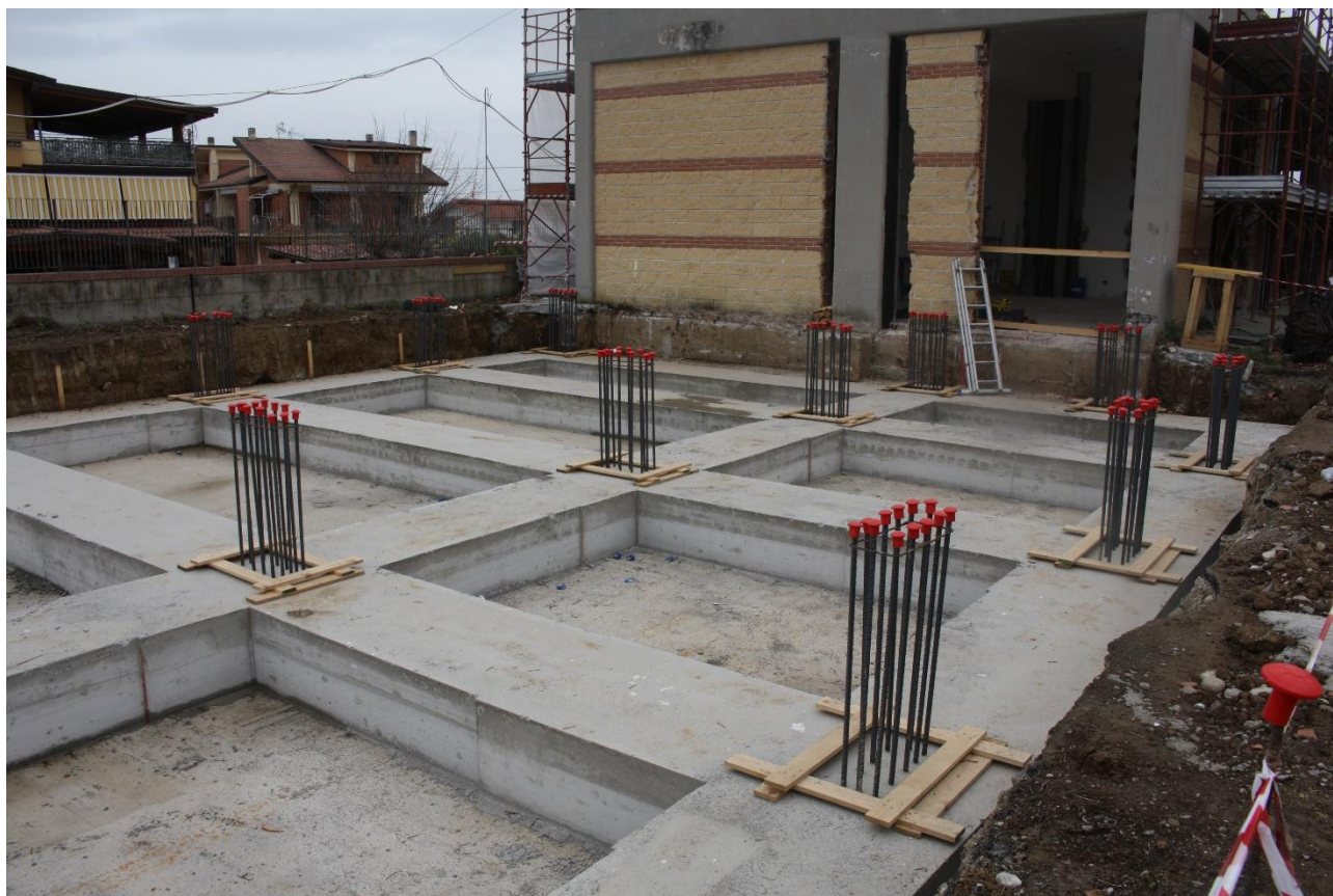
Figura 15 Realizzazione platea, rilievi fotografici del 25/03/2025
