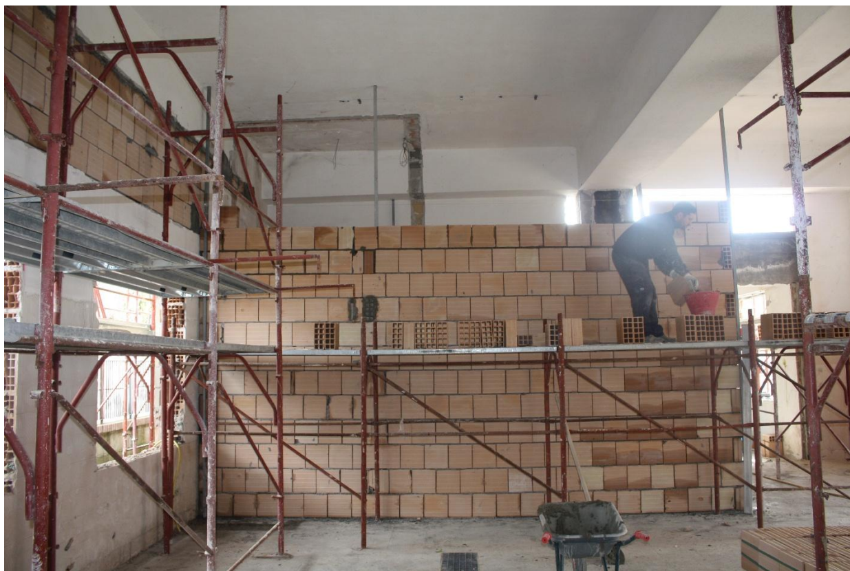
Figura 8 Realizzazione tramezzi interni, rilievi fotografici del 02/04/2025
