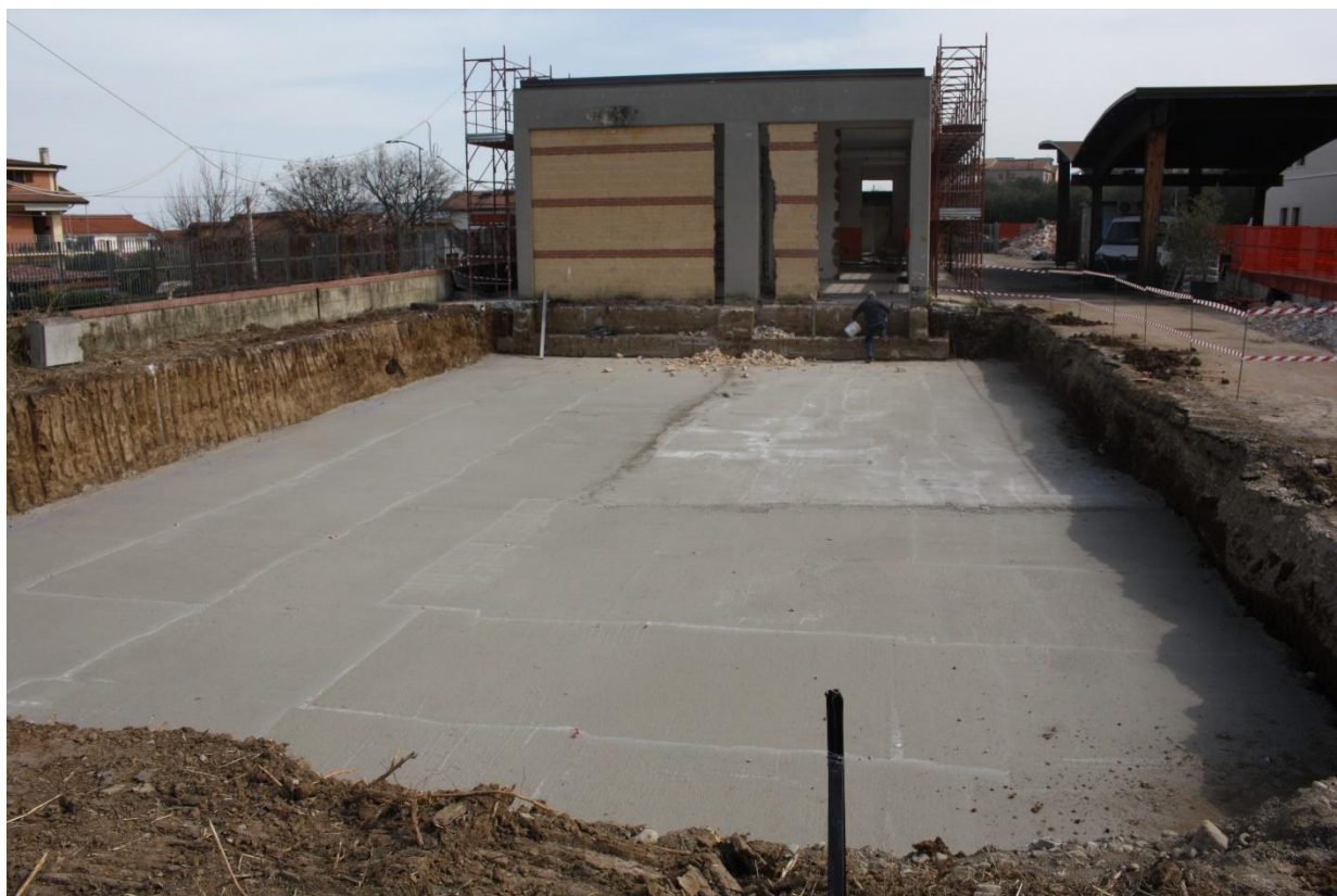
Figura 12 Realizzazione magrone, rilievi fotografici del 07/03/2025
