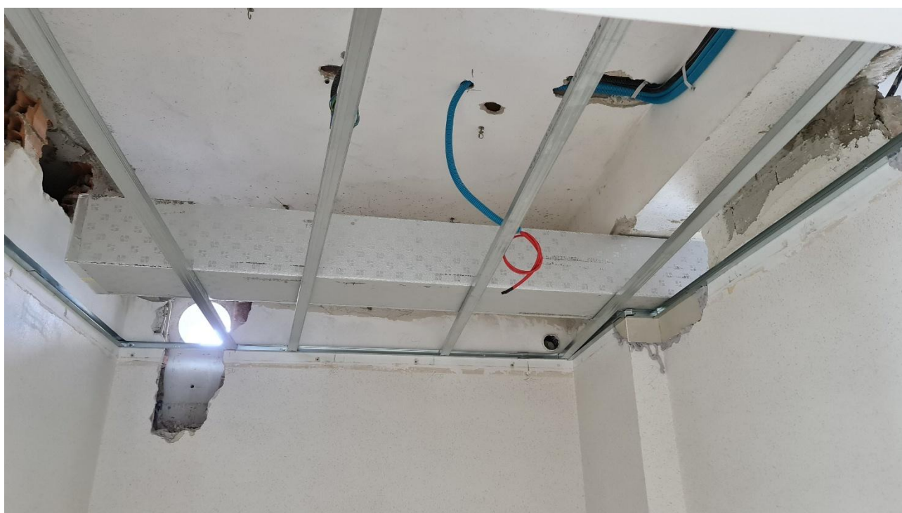
Figura 17 Realizzazione controsoffittatura, rilievo fotografico 18/09/2025
