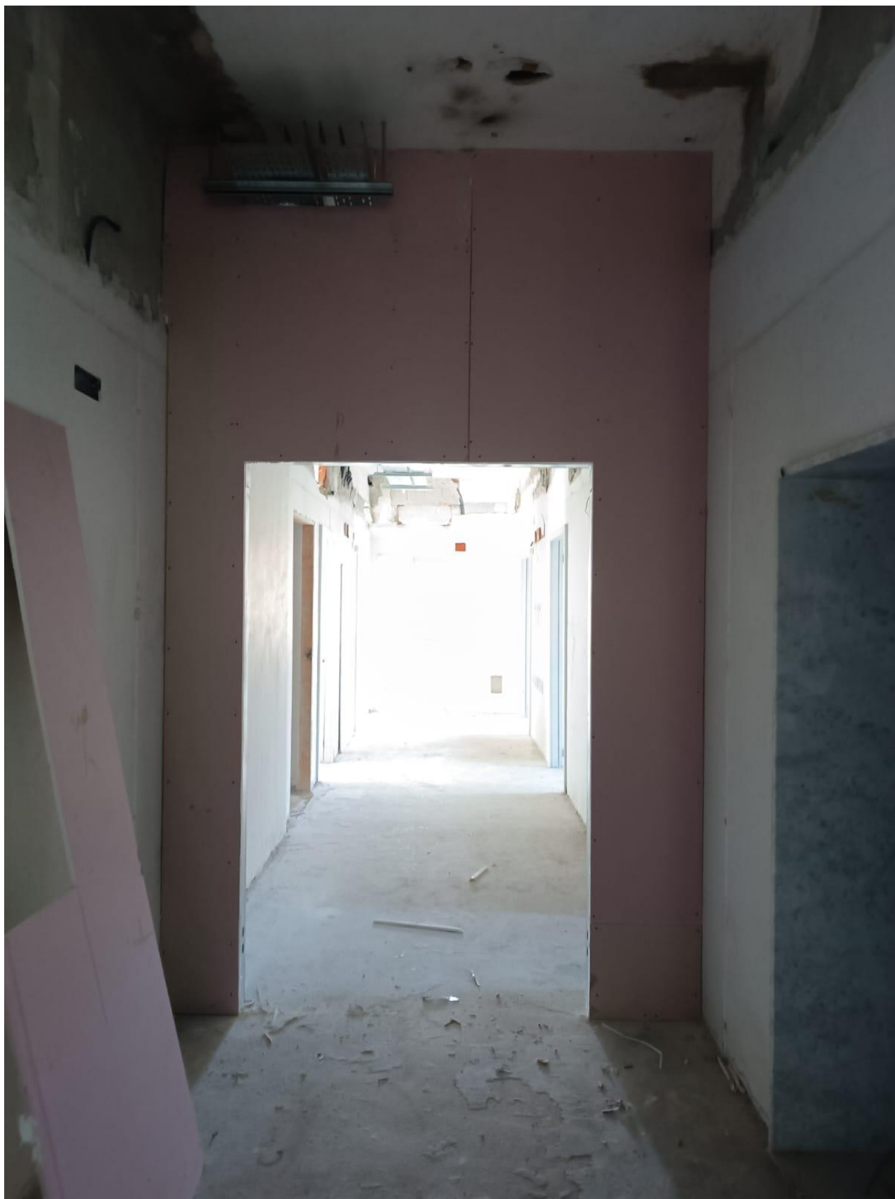
Figura 8 Nuovi divisori, rilievo fotografico del 05/07/2025
