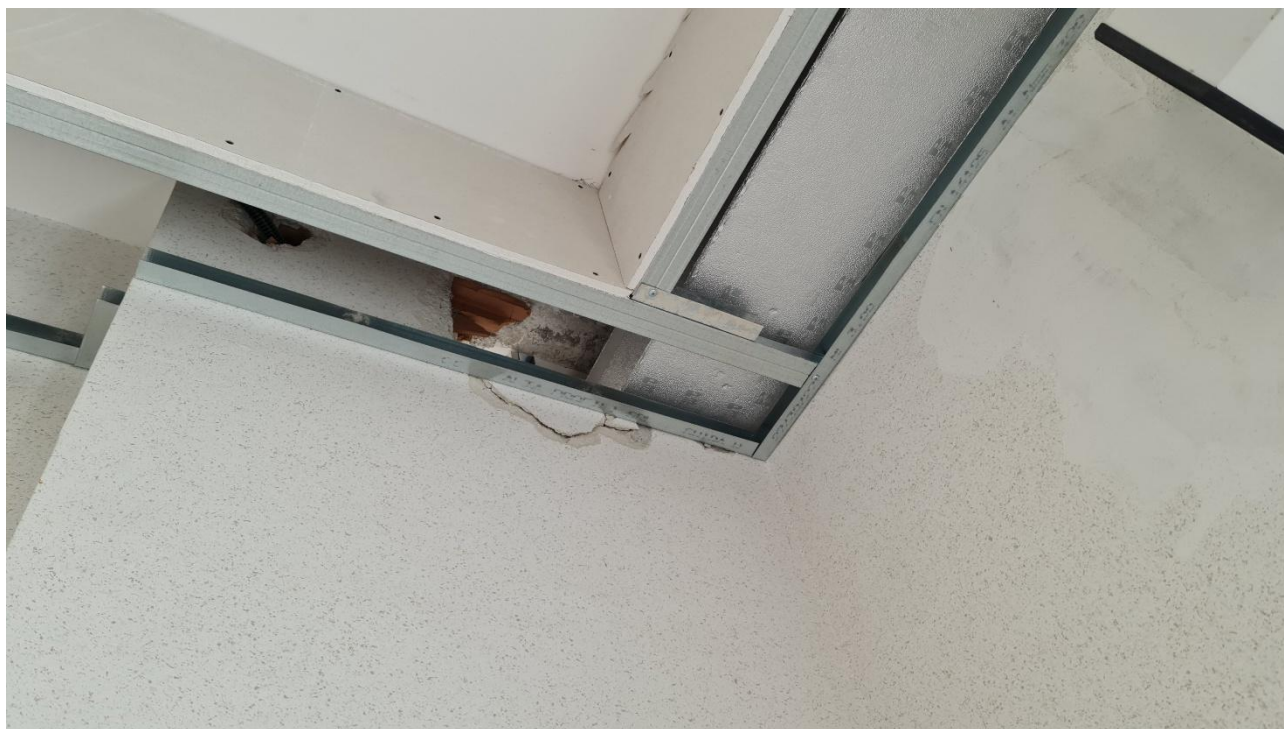
Figura 16 Realizzazione controsoffittatura, rilievo fotografico 18/09/2025
