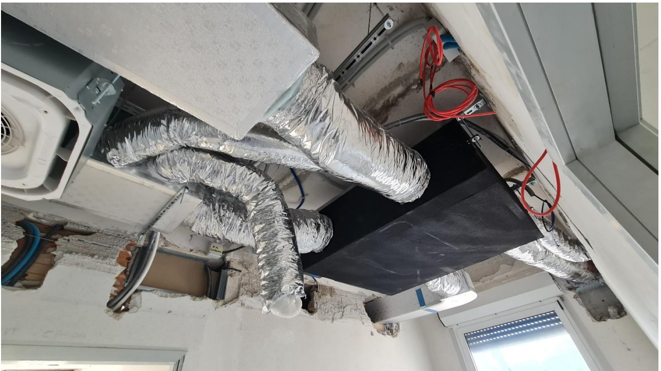
Figura 22 Ripristino Impianto di areazione, rilievo fotografico 18/09/2025
