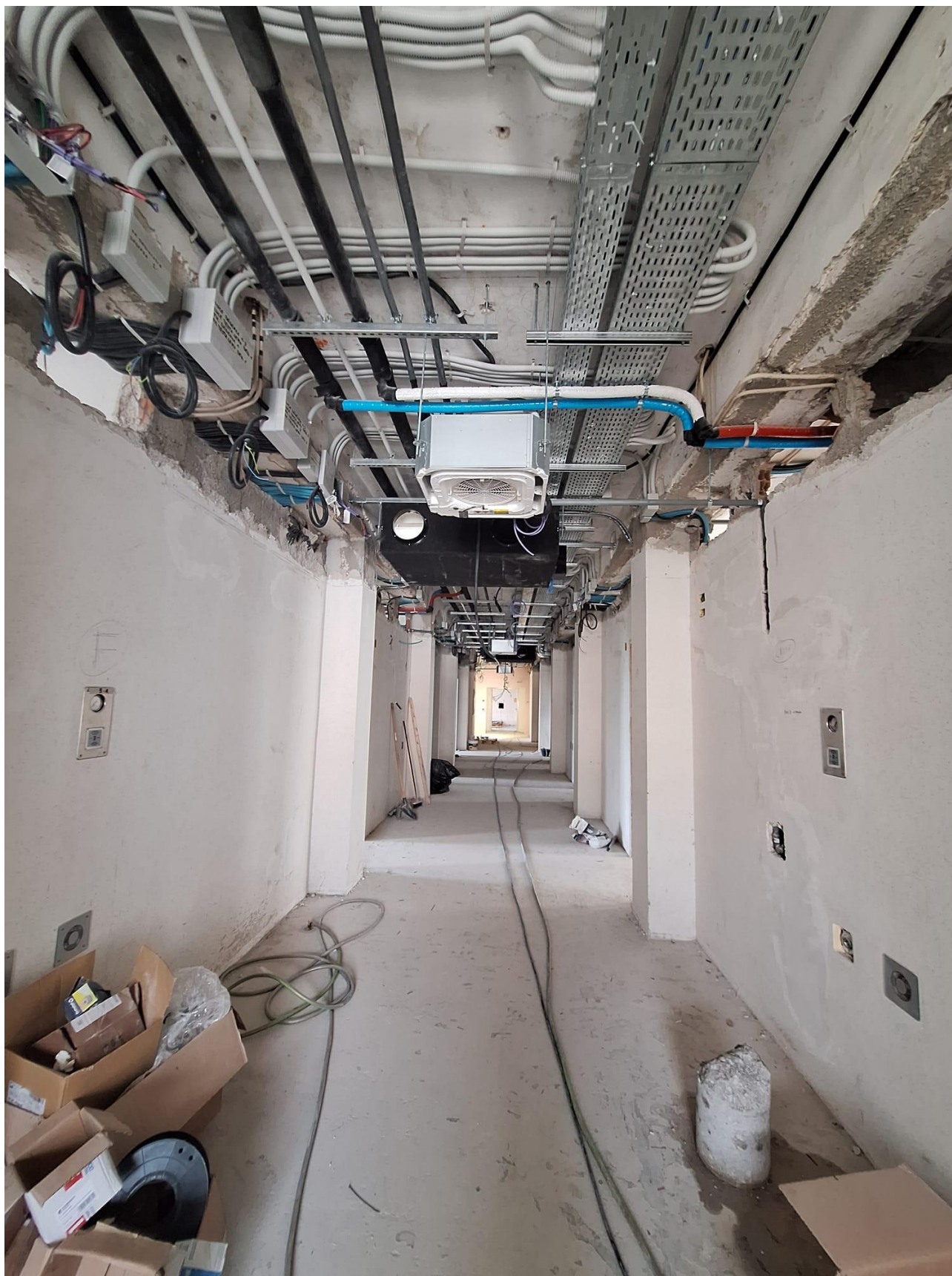
Figura 6 realizzazione impianti di climatizzazione, rilievo fotografico del 13/05/2024
